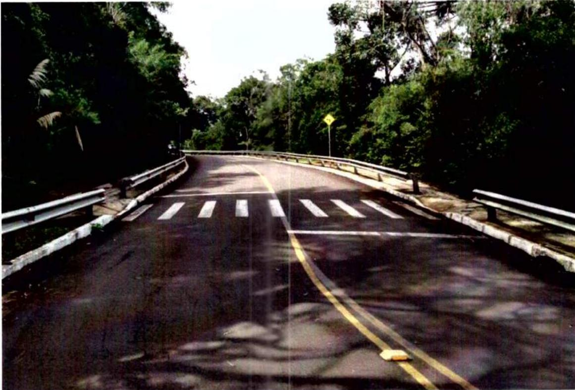
**Imagem 88.** Trecho de subida da Rua Berna, com a presença de faixa de segurança, placa indicativa de curva à esquerda, *guard rails*, calçada com piso tátil, além de saídas para rede pluvial.
