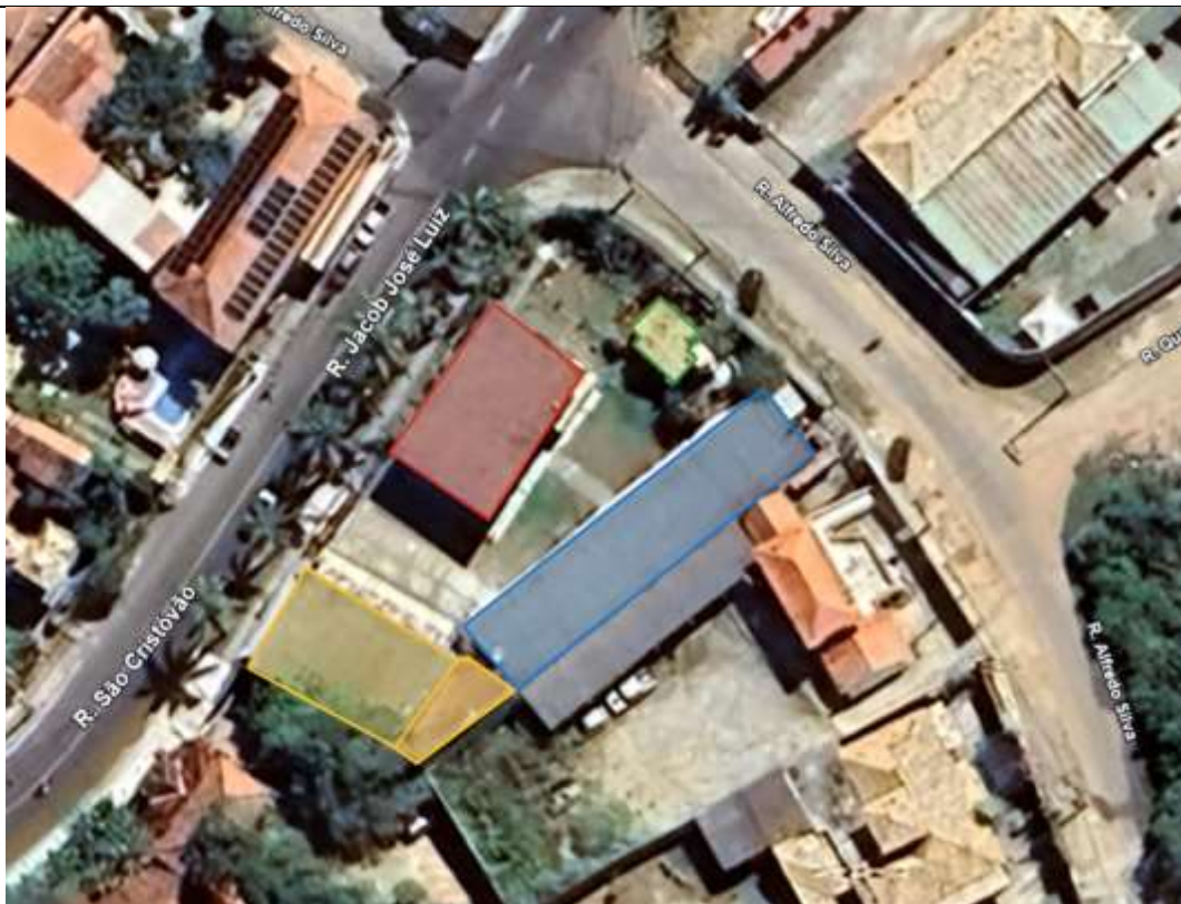
Figura 03 – Benfeitorias do imóvel.
