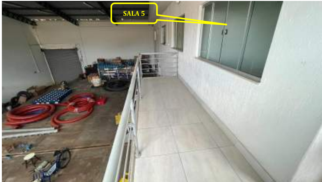
FOTO 19 - VISTA DO MEZANINO NA PARTE POSTERIOR, COM ACABAMENTOS E GUARDACORPO PADRÃO NBR 9050.
