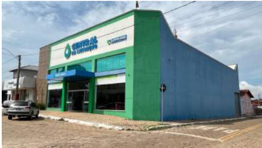
FOTO 2 – CARACTERIZAÇÃO DA EDIFICAÇÃO
