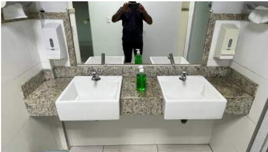
FOTO 24 - LAVATORIOS COM ACABAMENTOS DE ALTO PADRÃO E COM ASPECTO DE NOVO
