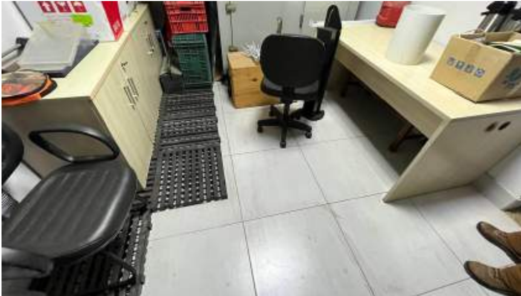
FOTO 37 - VISTA DO PISO DA SALA DA CAMARA FRIA
