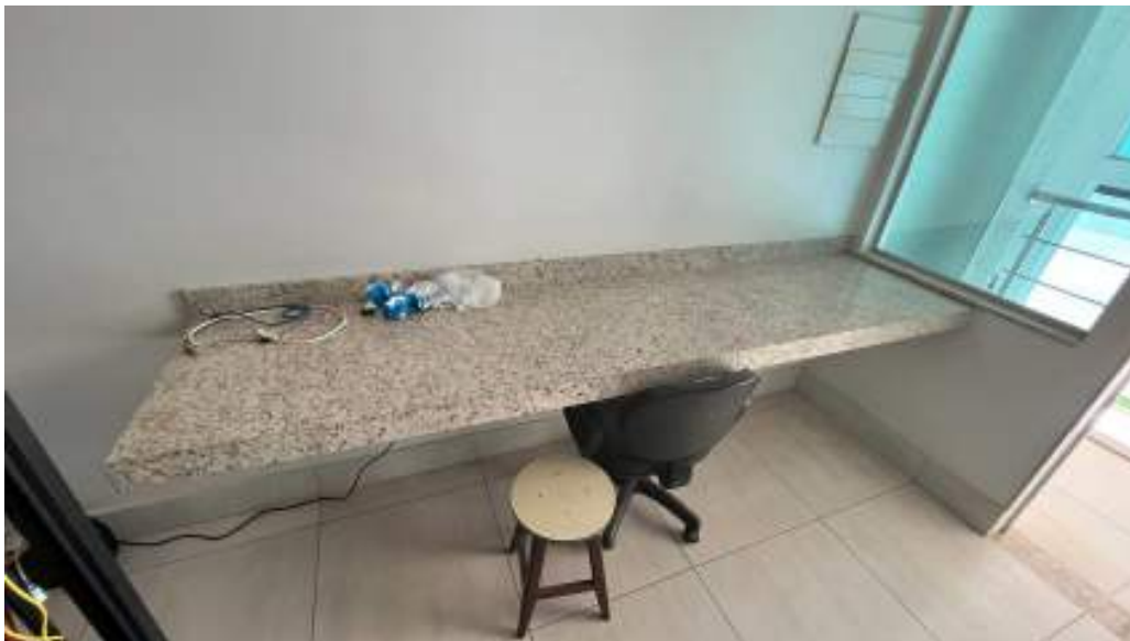
FOTO 10 - OUTRA IMAGEM SALA 2 – ACABAMENTOS INTACTOS COM ASPECTO DE NOVO
