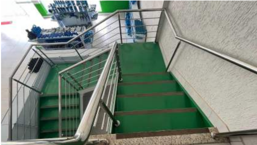
FOTO 21 - ESCADA METALICA COM ACABAMENTOS DE PRIMEIRA E GUARDA CORPO EM INOX
