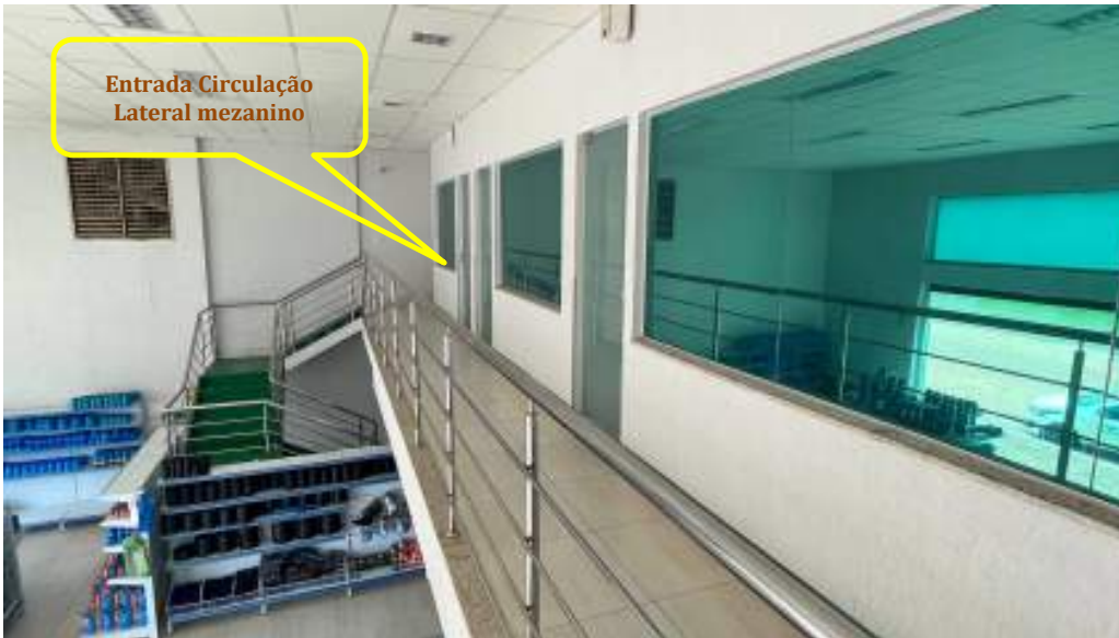
FOTO 17 - IMAGEM DO MEZANINO - VISTA ENTRADA DA CIRCULAÇÃO LATERAL
