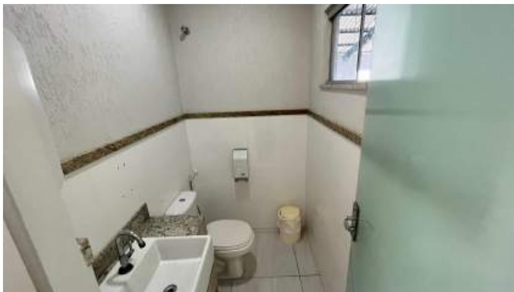
FOTO 8 - IMAGEM INTERNA BANHO SALA 1 – ACABAMENTOS COM ASPECTO DE NOVO
