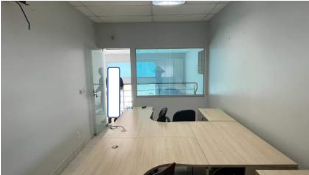
FOTO 15 - IMAGEM SALA 5 - ACABAMENTOS INTACTOS COM ASPECTO DE NOVO
