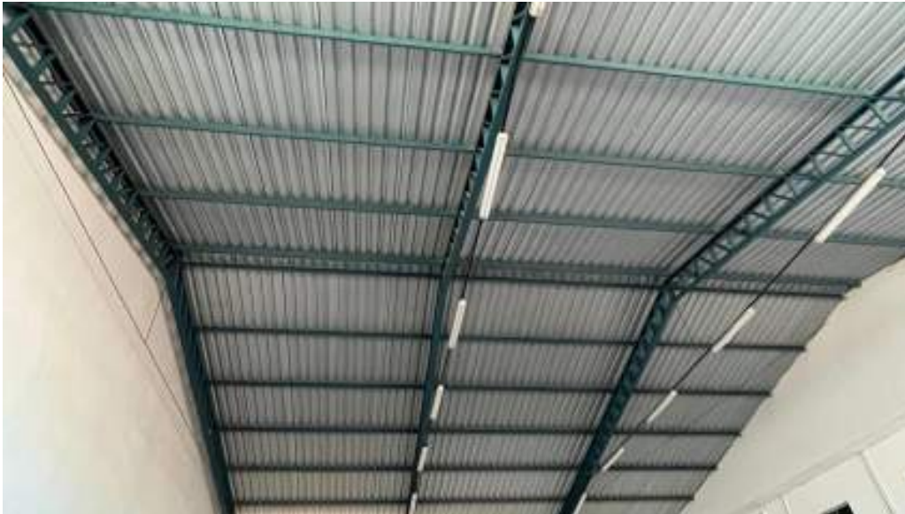
FOTO 35 - VISTA DA ESTRUTURA METALICA E TELAHDO METALICO
