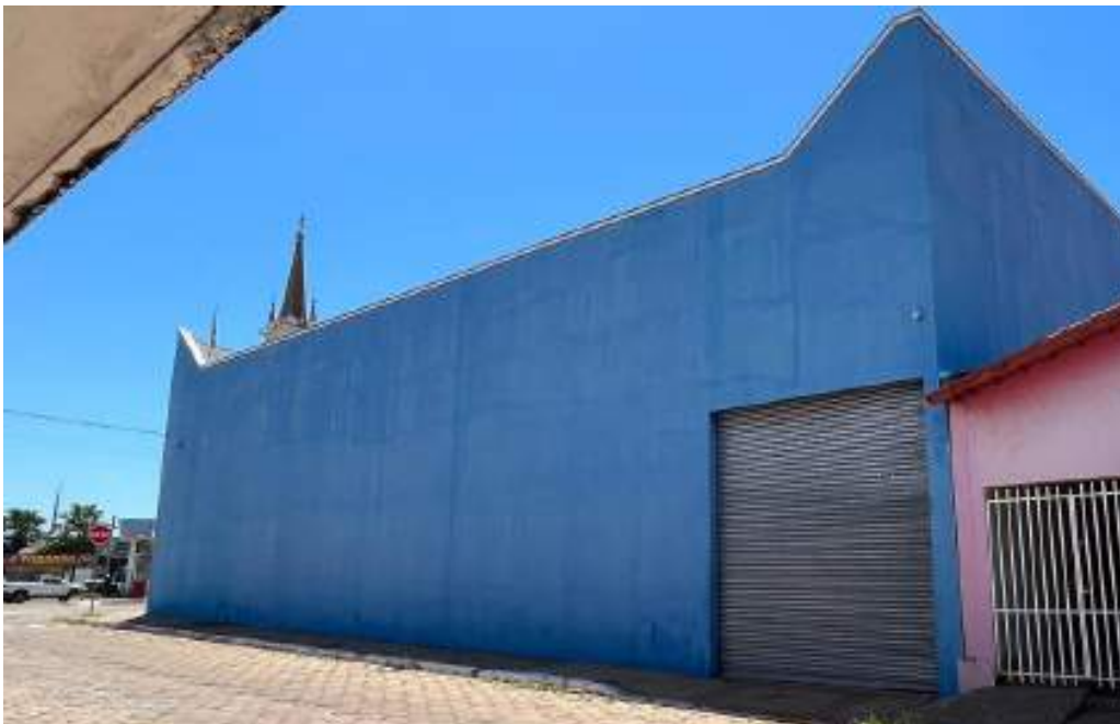
FOTO 40 - VISTA LATERAL EXTERNA / PORTA DE ACESSO AO GALPÃO POSTERIOR
