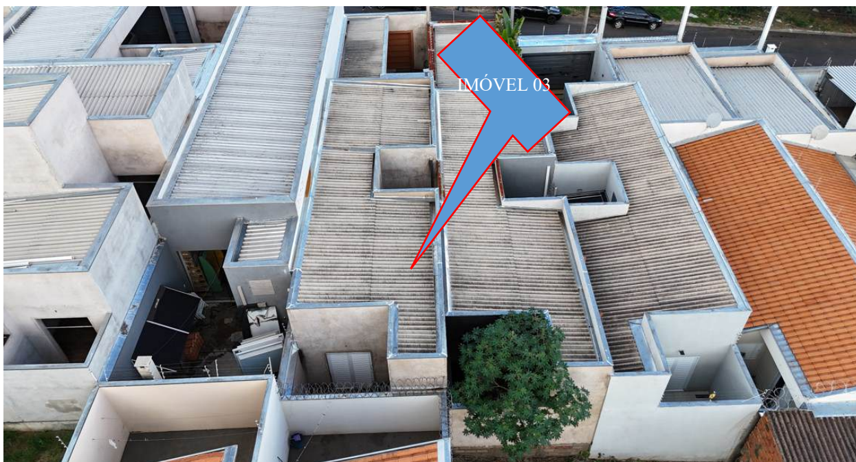
FOTO 47> DETALHE DO IMÓVEL 03, VISTO PELA RETAGUARDA.
