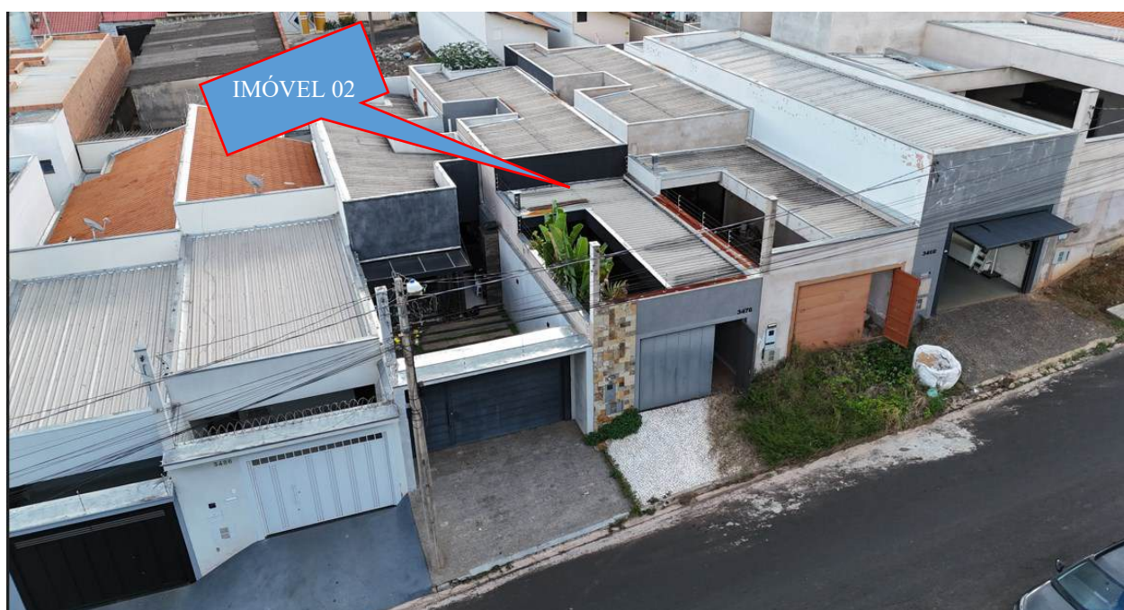
FOTO 08> DETALHE DO IMÓVEL 02, VISTO POR CIMA.
