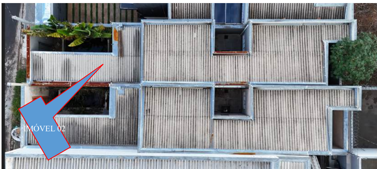
FOTO 10> DETALHE DO IMÓVEL 02, VISTO POR CIMA.
