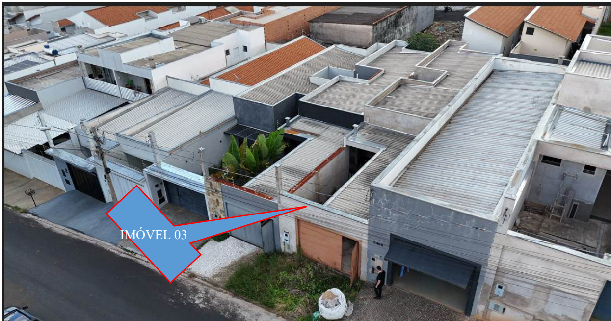
FOTO 44> DETALHE DA FACHADA DO IMÓVEL 03, VISTO POR CIMA.
