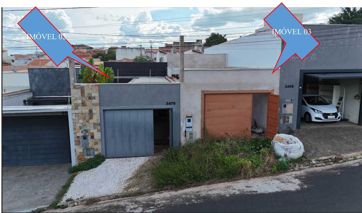
FOTO 46> DETALHE DAS FACHADAS DO IMÓVEL 02 E 03.
