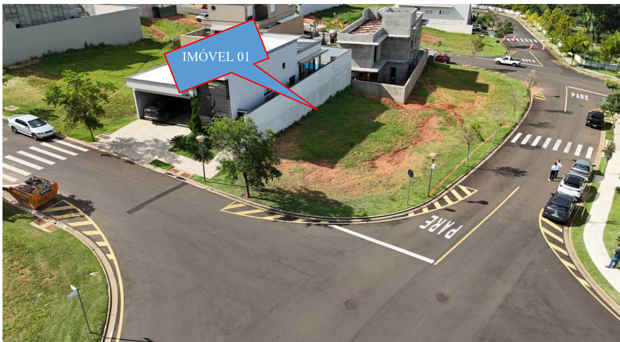
FOTO 04> DETALHE DO IMÓVEL 01.
