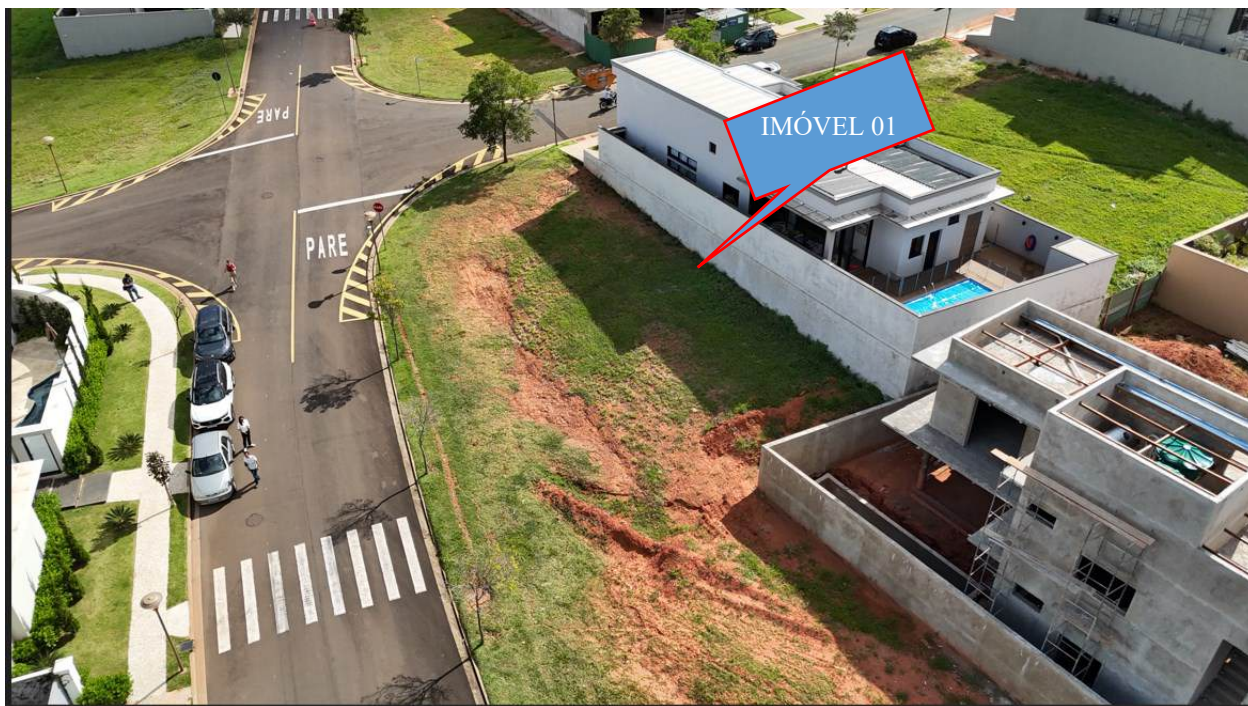
FOTO 05> DETALHE DO IMÓVEL 01, VISTO POR CIMA PELA RETAGUARDA.
