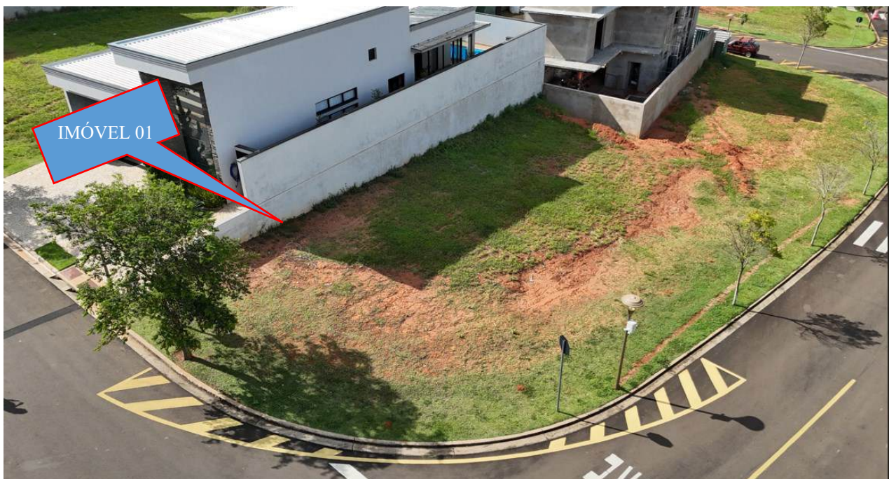
FOTO 02> DETALHE DO IMÓVEL 01.
