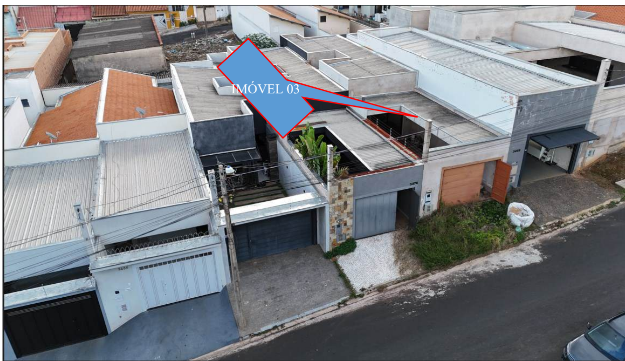
FOTO 45> DETALHE DA FACHADA DO IMÓVEL 03, VISTO POR CIMA DE OUTRO ÂNGULO.
