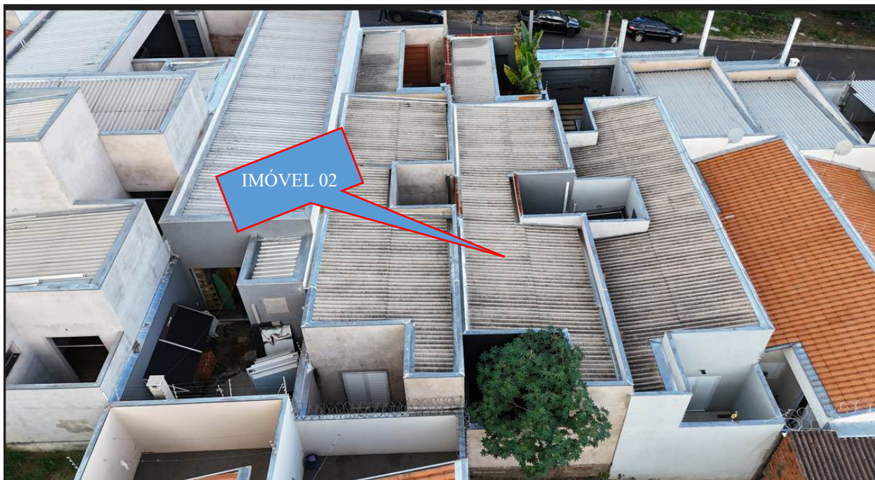
FOTO 09> DETALHE DO IMÓVEL 02, VISTO POR CIMA, PELA RETAGUARDA.
