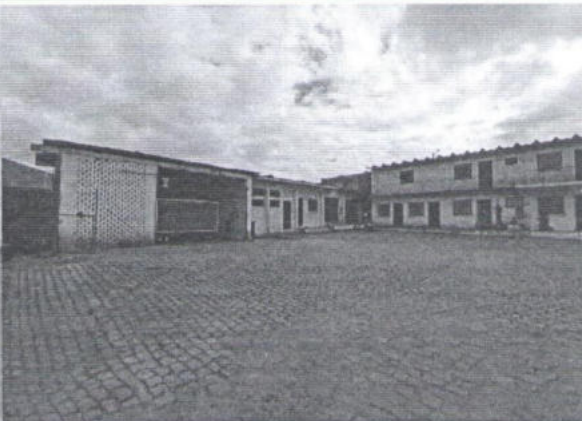
As benfeitorias localizadas sobre o imóvel estão em péssimas condições
