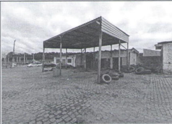
Vista do imóvel onde nas construções tem uma borracharia funcionando
