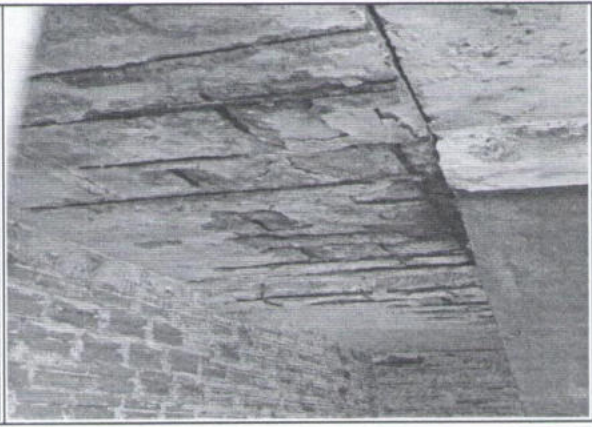
Parte que possui o 2º andar, sendo que o piso superior aparece os ferros
