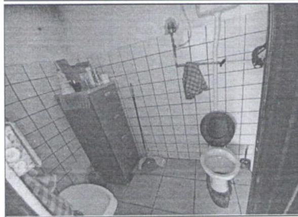
Foto do banheiro que é usado pelos funcionários da lavagem ao lado do posto
