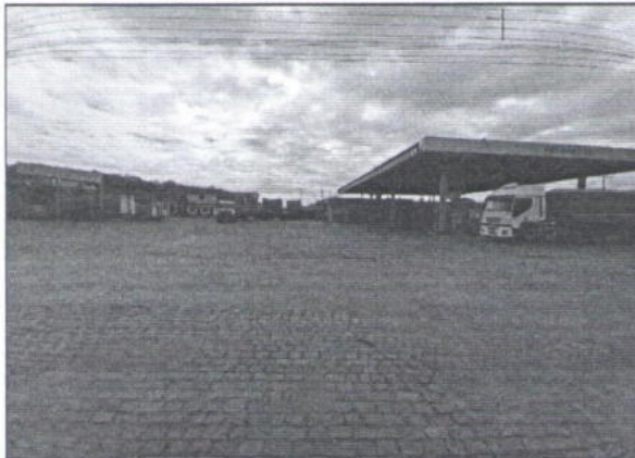
Vista do imóvel a ser periciado, ao lado do posto de combustíveis
