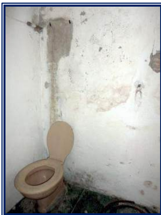
Térreo ( casa 02 ): Banheiro.
