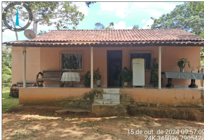
Ilustração fotográfica 03: Vista parcial da casa 01 da Dona Ivone, localizada no imóvel objeto da presente ação, Terra Roxa, Farturinha, zona rural do Município de São Gabriel da Palha – ES.
