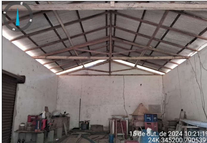
Ilustração fotográfica 09: Vista parcial do galpão localizada no imóvel objeto da presente ação, Terra Roxa, Farturinha, zona rural do Município de São Gabriel da Palha – ES.
