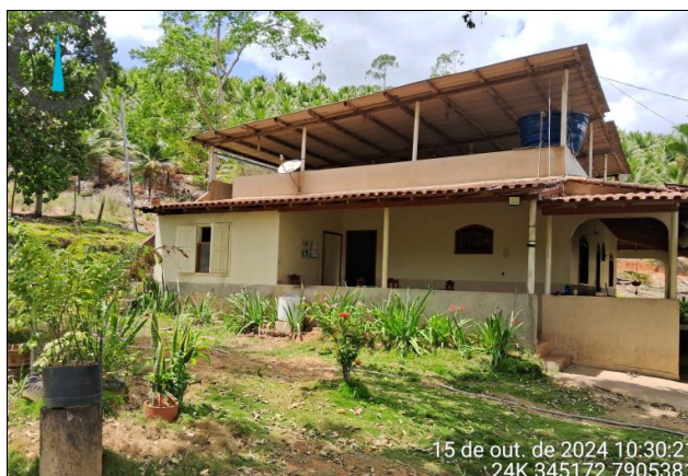
Ilustração fotográfica 11: Vista parcial da casa sede, localizada no imóvel objeto da presente ação, Terra Roxa, Farturinha, zona rural do Município de São Gabriel da Palha – ES.
