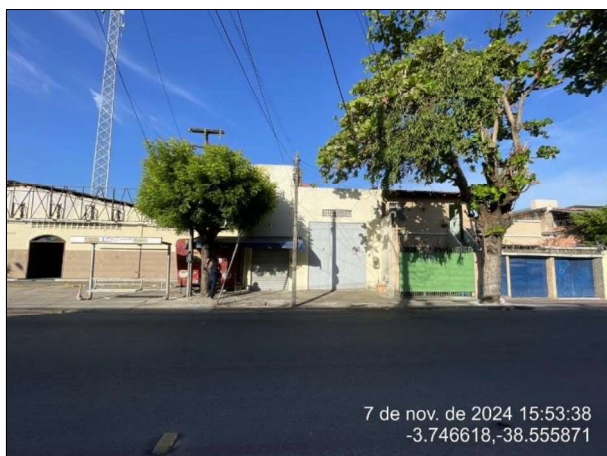
Figura 1 - Vista geral da fachada principal do imóvel avaliando.
