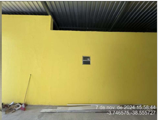
Figura 8 - Vista geral da edificação da cozinha e do escritório.
