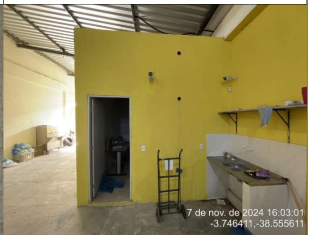
Figura 12 - Vista geral da edificação da cozinha e do escritório.
