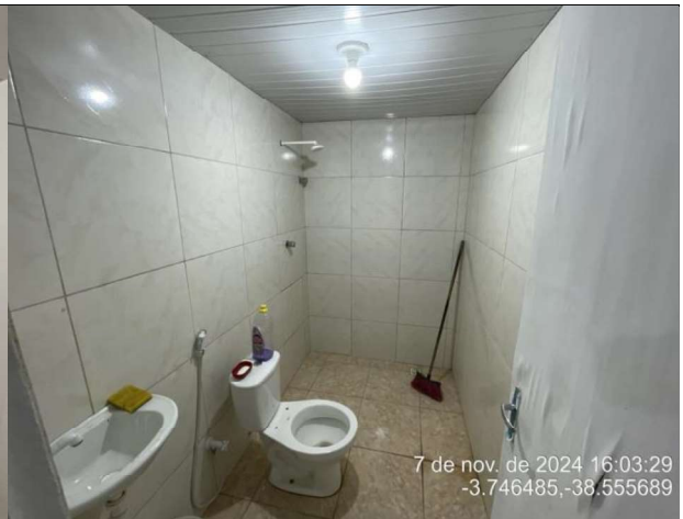
Figura 14 - Vista interna do banheiro do imóvel avaliando.
