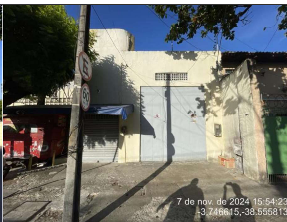
Figura 2 - Vista geral da fachada principal do imóvel avaliando.
