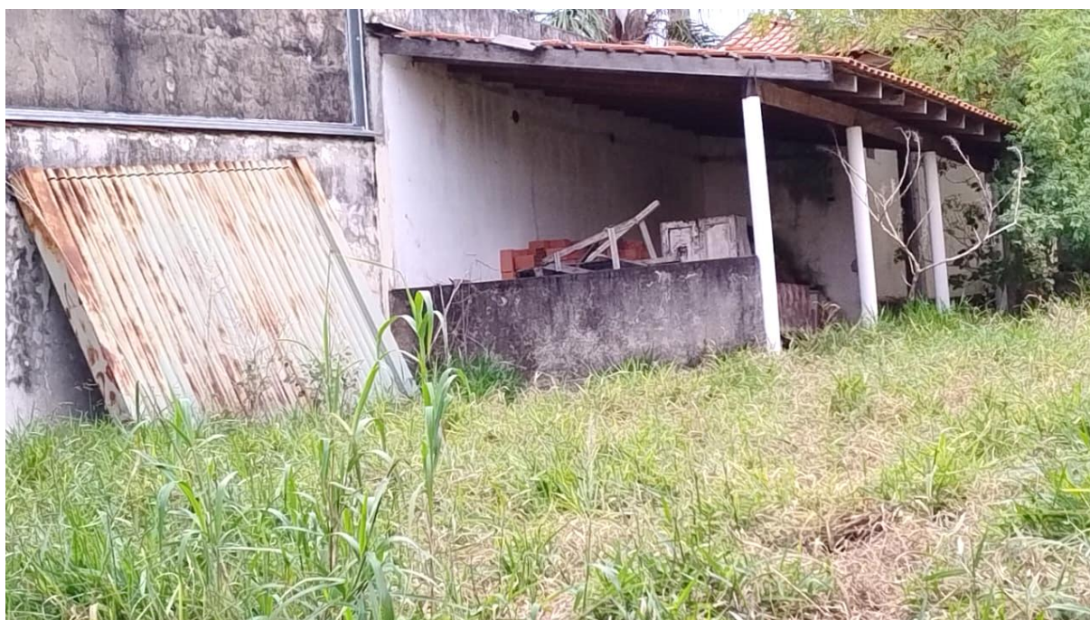
Foto 06 – Vista da cobertura lateral
