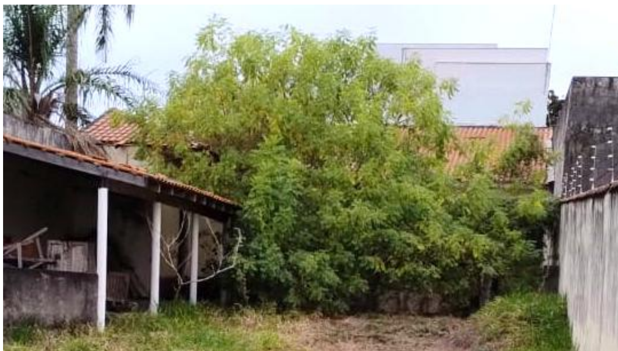
Foto 05 – Vista da construção principal nos fundos, não foi possível realizar a vistoria interna da construção, visto que o portão de acesso estava fechado e não houve representantes das partes acompanhando a vistoria
