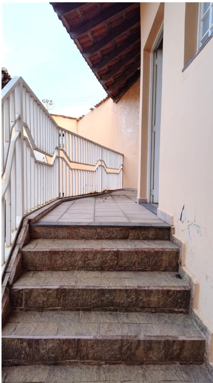
Foto 42 – Vista da escada de acesso ao andar superior da edícula
