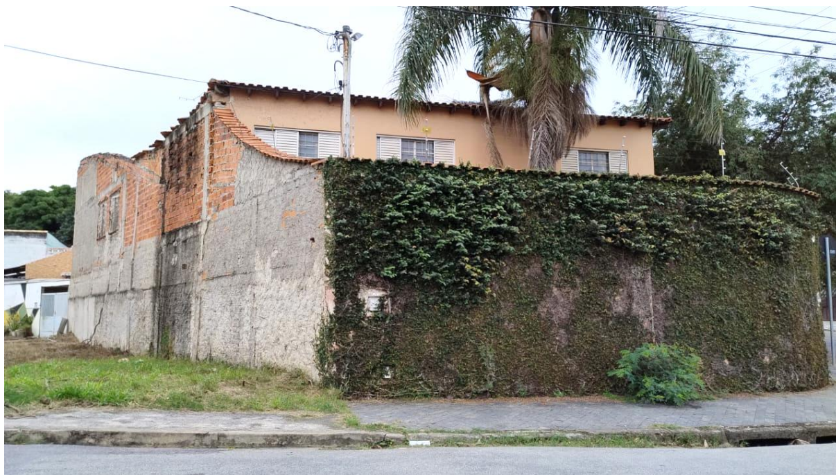
Foto 07 – Vista da fachada lateral / fundos do imóvel avaliando
