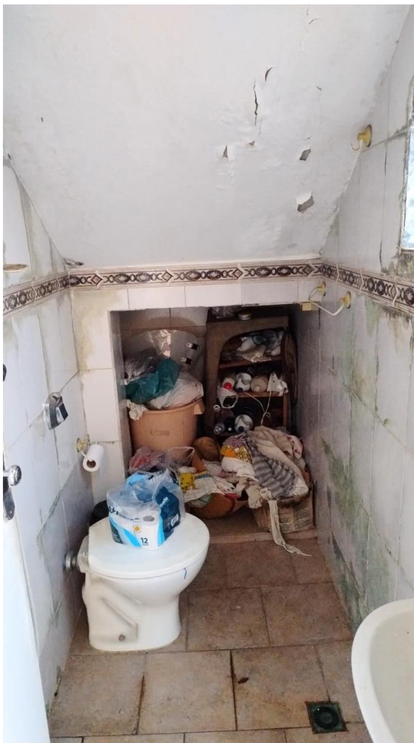
Foto 40 – Vista do banheiro junto a área de serviço
