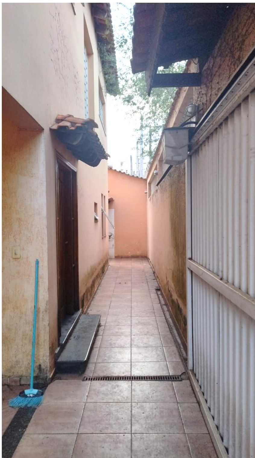
Foto 08 – Vista recuo frontal junto a garagem
