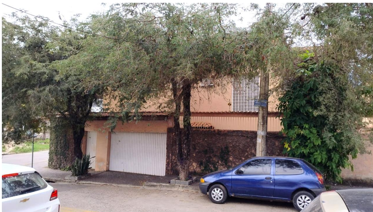
Foto 03 – Vista geral da fachada principal do imóvel avaliando pela Rua Curupaiti
