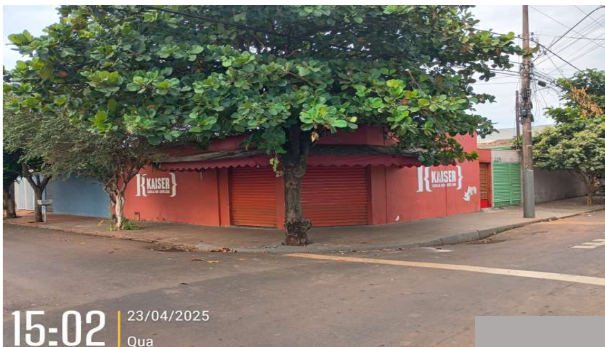
Fachada do imóvel diligenciado.
