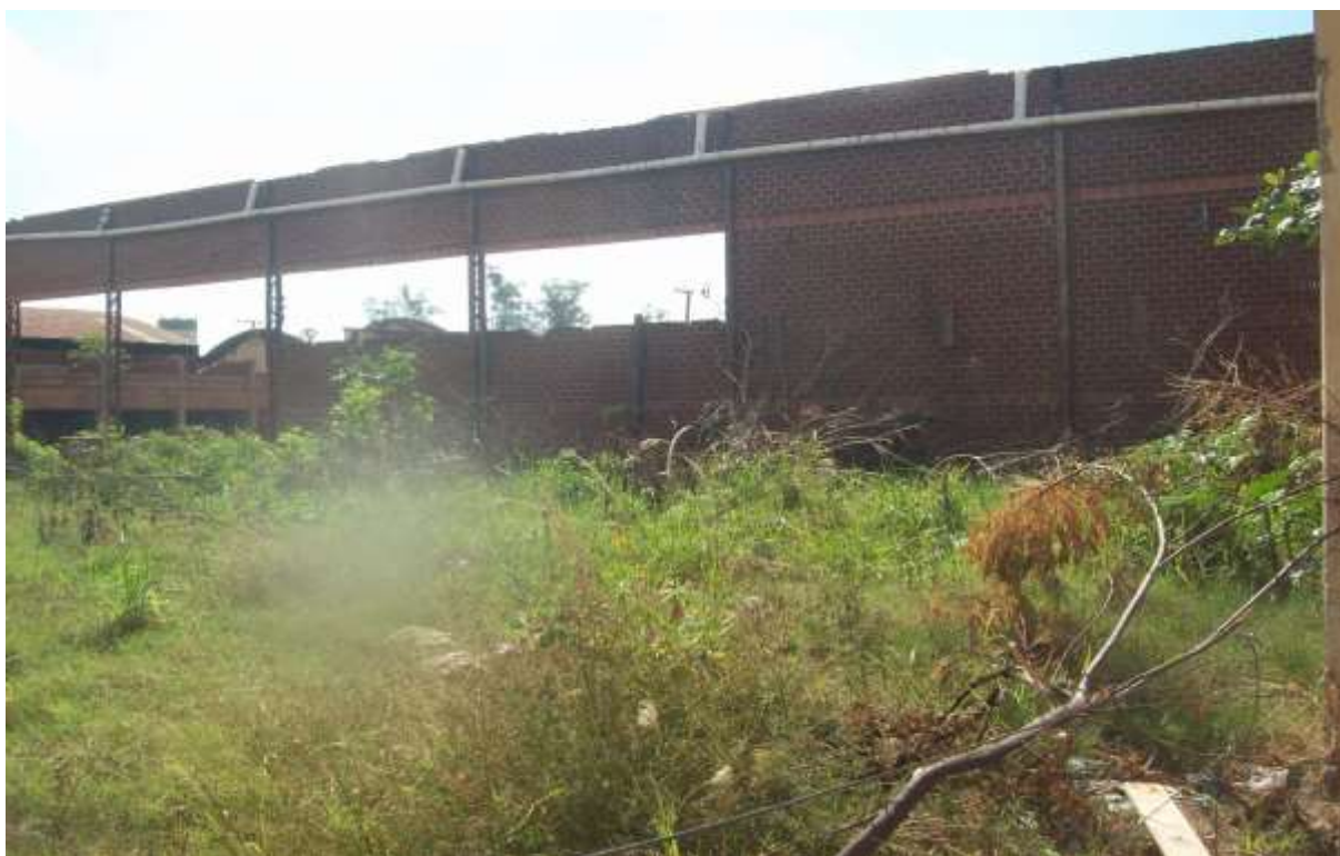
Foto 06: Vista interna do imóvel
