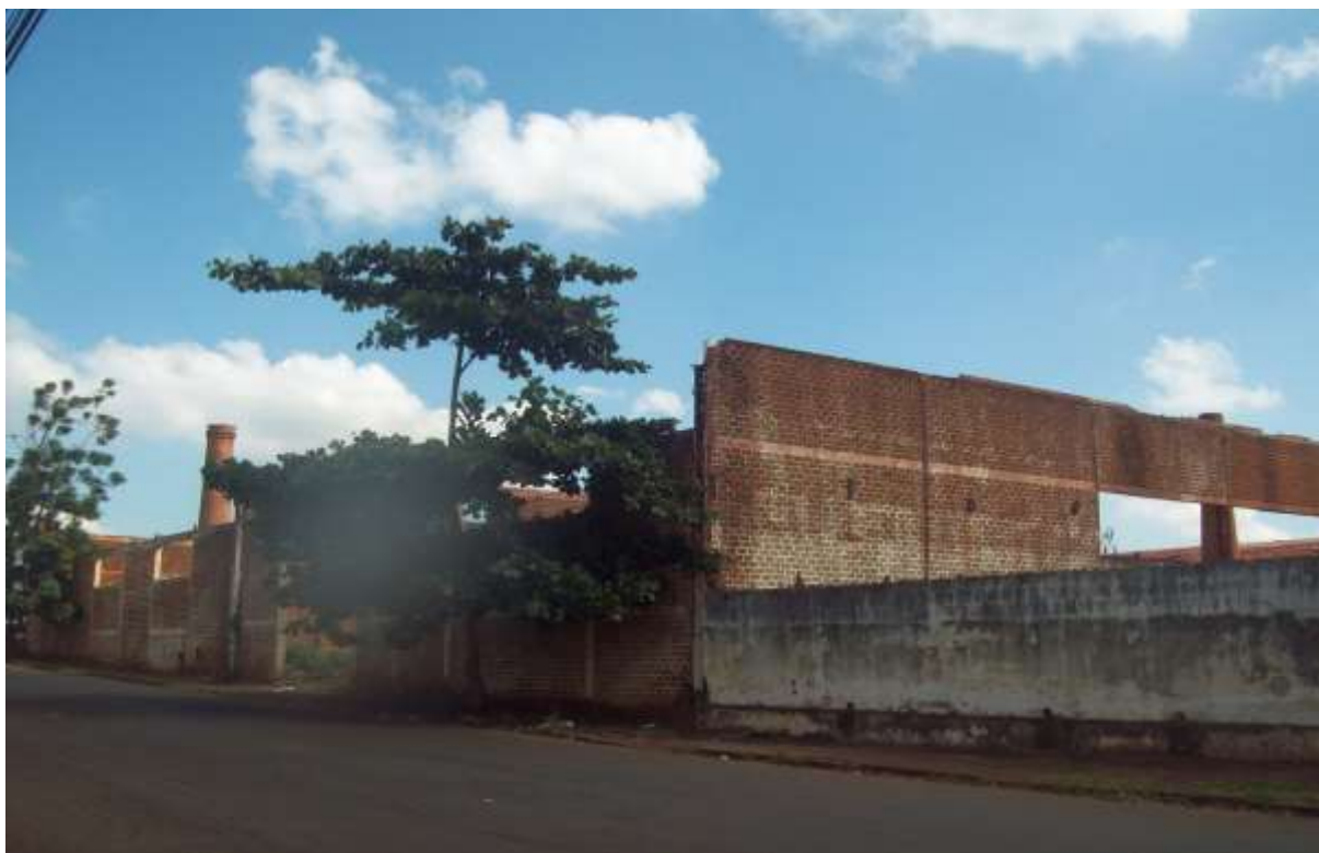
Foto 13: Testada do imóvel.
