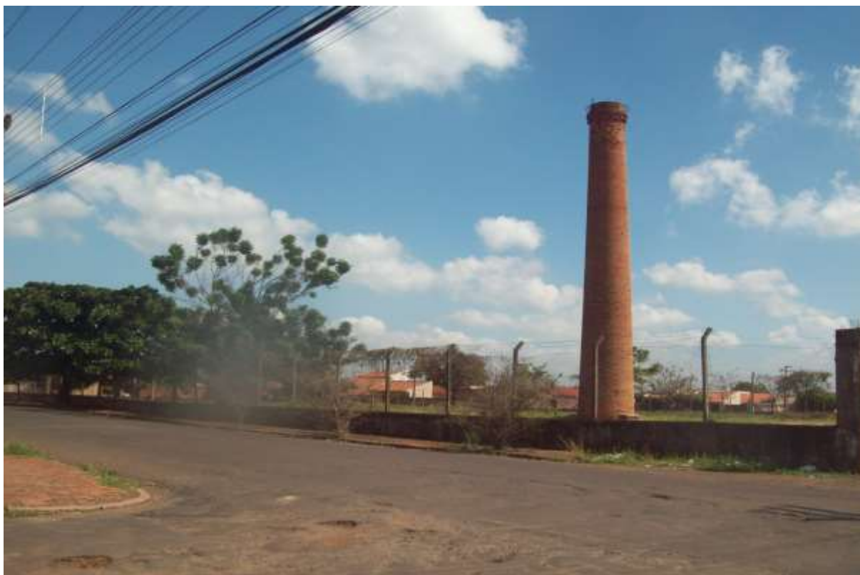
Foto 09: Testada do imóvel
