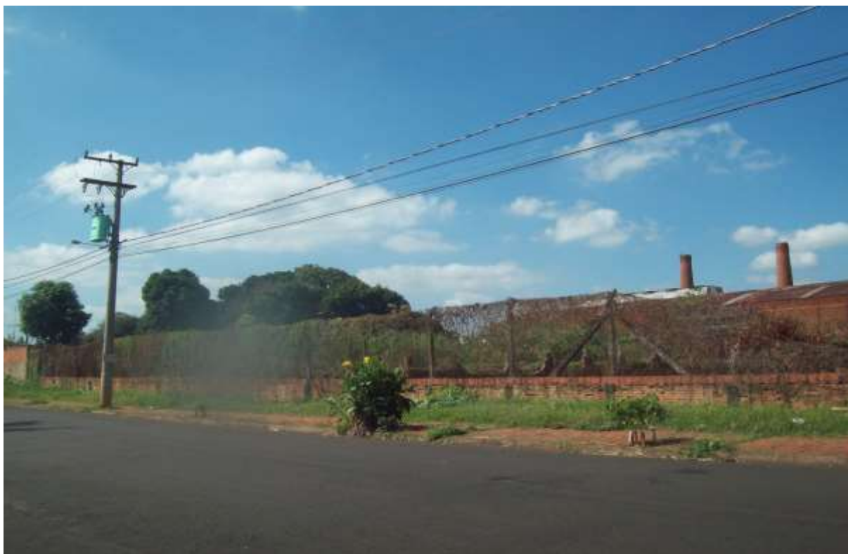
Foto 15: Testada do imóvel.
