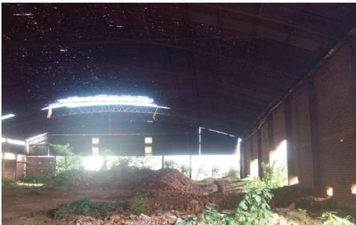
Foto 12: Vista interna do imóvel
