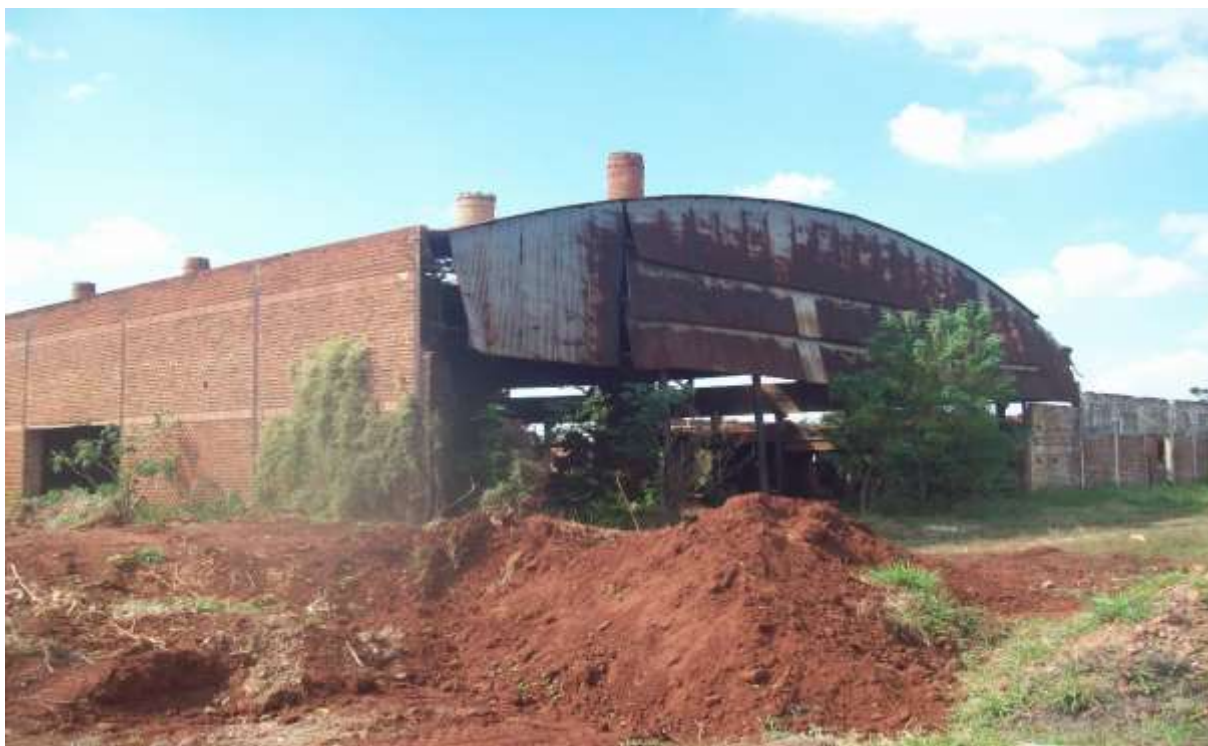
Foto 11: Testada do imóvel
