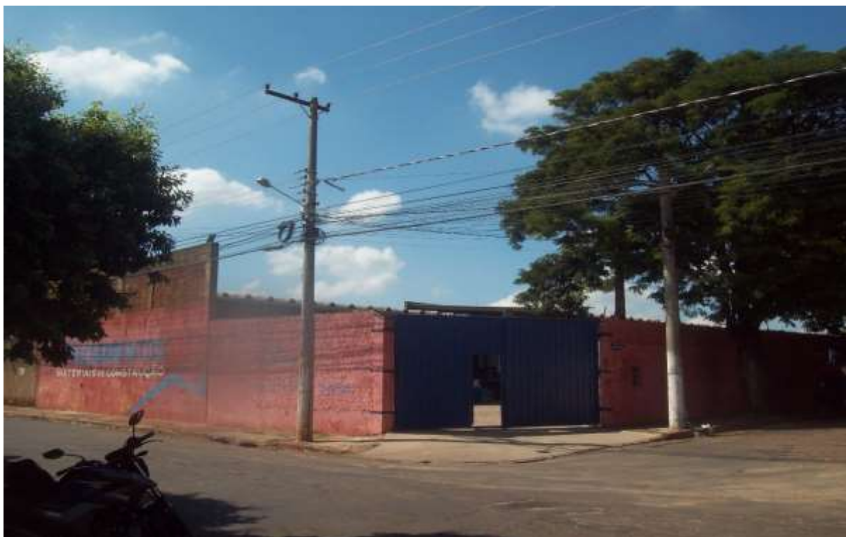
Foto 01: Fachada do imóvel.
