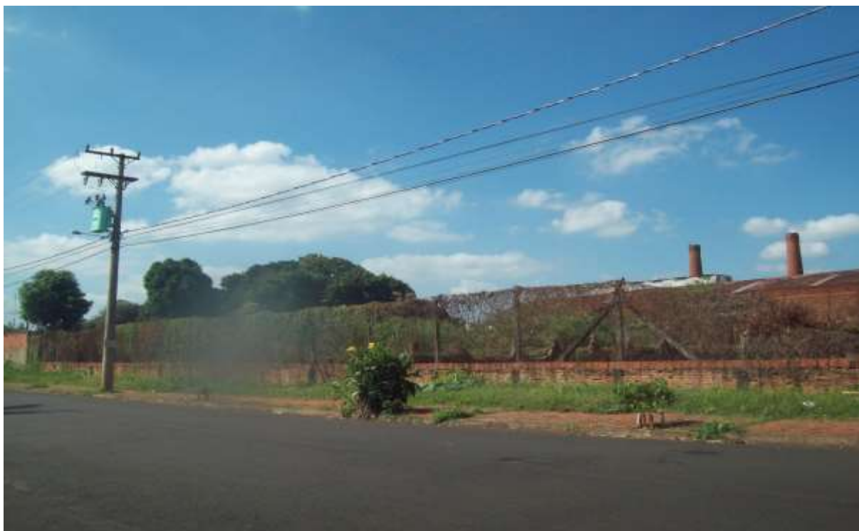
Foto 03: Testada do imóvel.
