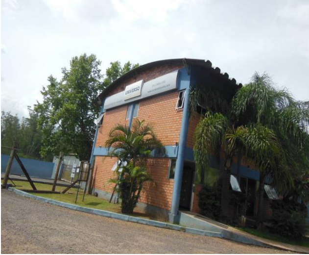
Prédio da administração com dois pavimentos
