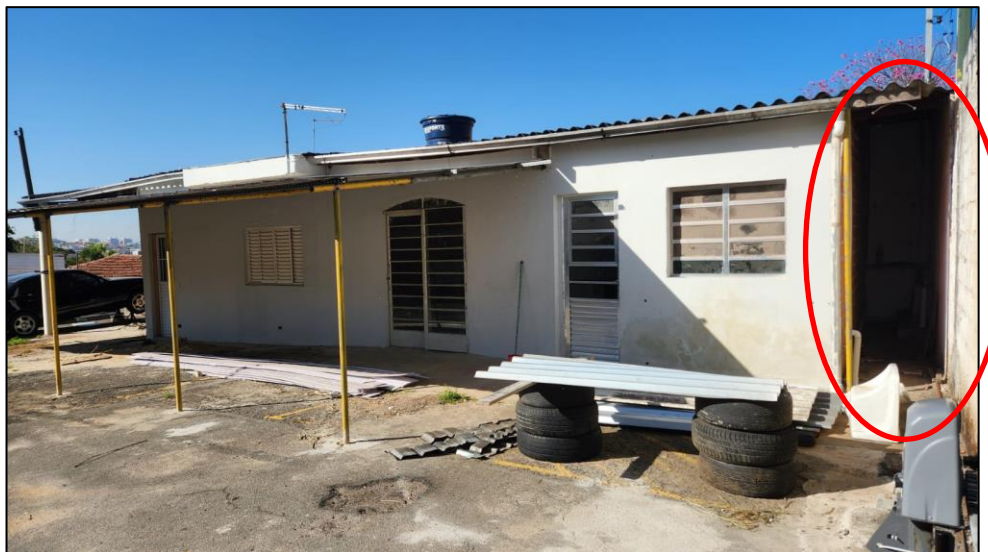
Foto 05 – Vista do lado direito (detalhe para o recuo de aproximadamente 1m do muro frontal)
