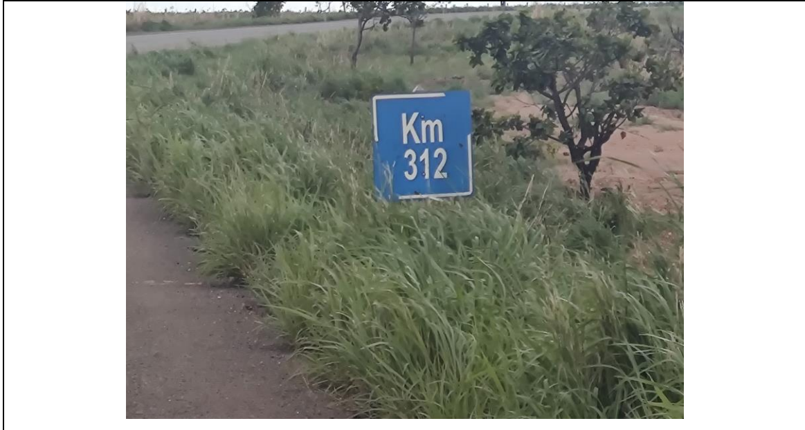
Fotografia 11: Vista da rodovia lote 07
