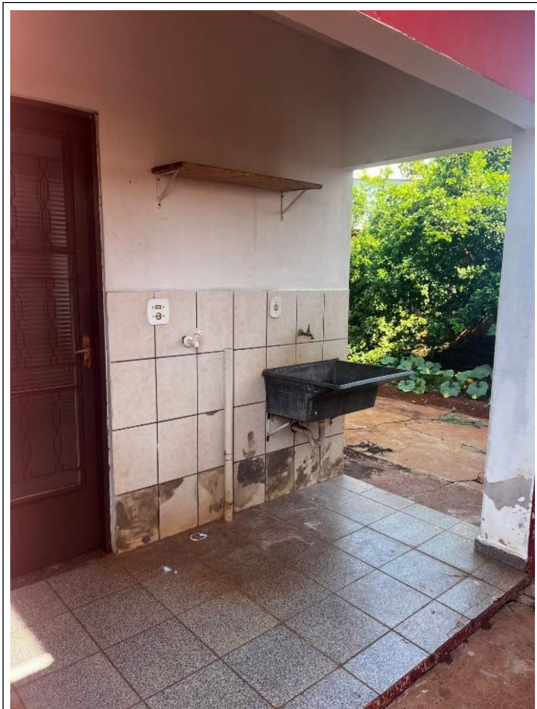
FOTO 10 – Vista parcial da lavanderia do imóvel
