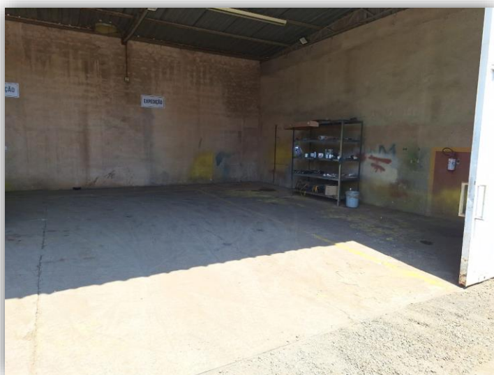
Na área frontal (de quem olha da avenida) foi constatada uma benfeitoria parcial edificada, sendo um galpão atualmente utilizado pela empresa
