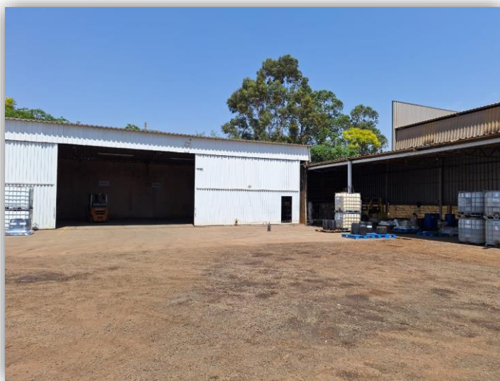
Na área frontal (de quem olha da avenida) foi constatada uma benfeitoria parcial edificada, sendo um galpão atualmente utilizado pela empresa
