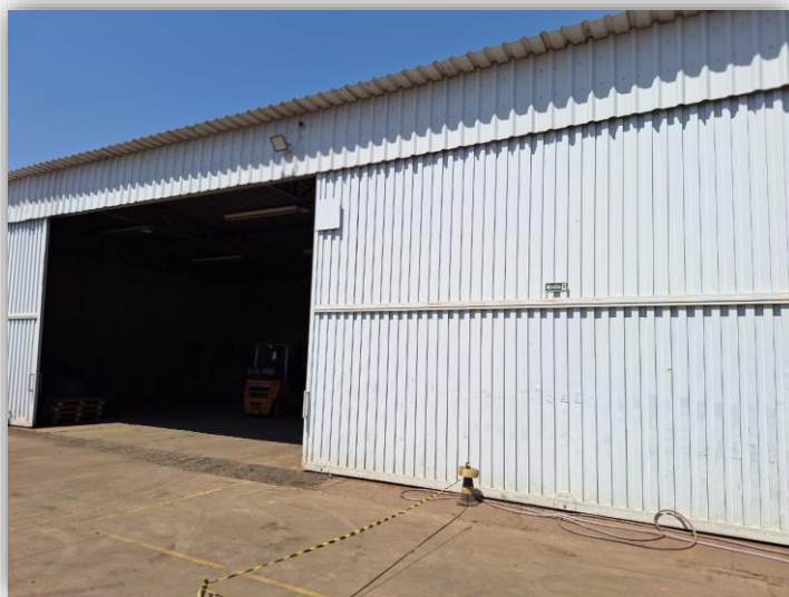
Na área frontal (de quem olha da avenida) foi constatada uma benfeitoria parcial edificada, sendo um galpão atualmente utilizado pela empresa
