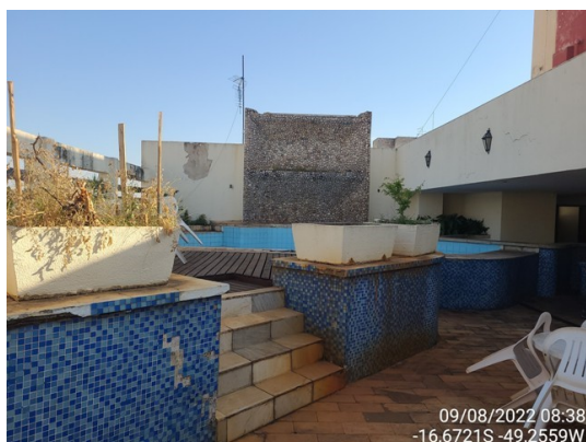
Foto 12 – Outra vista da área de lazer (cobertura)
