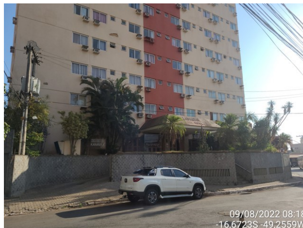
Foto 02 – Vista da fachada
