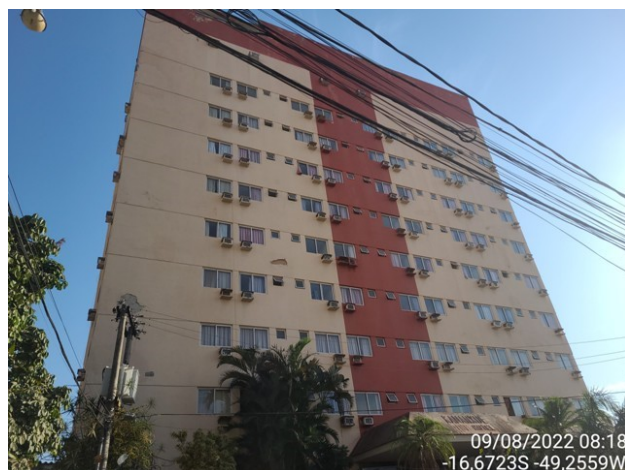
Foto 03 – Outra vista da fachada (frente)
