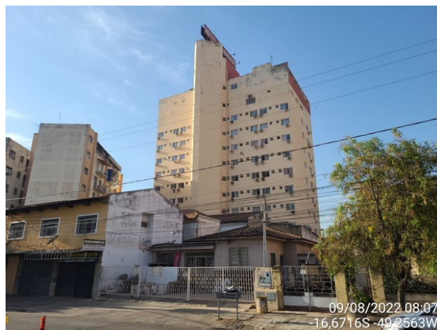
Foto 04 – Outra vista da fachada (fundos)
