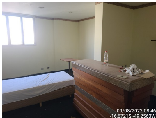
Foto 22 – Outra vista geral do 4º pavimento
