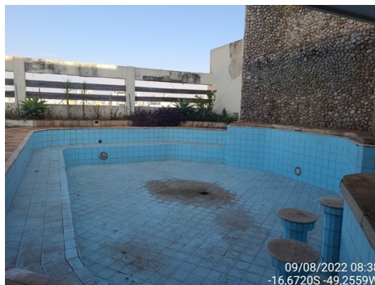
Foto 09 – Vista da área de lazer (cobertura)
