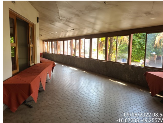
Foto 35 – Outra vista geral do térreo
