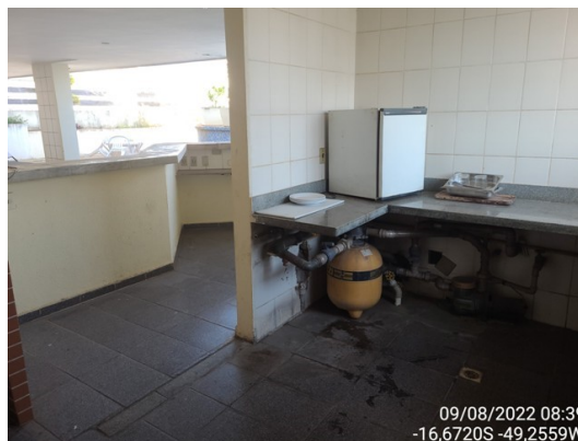
Foto 11 – Outra vista da área de lazer (cobertura)
