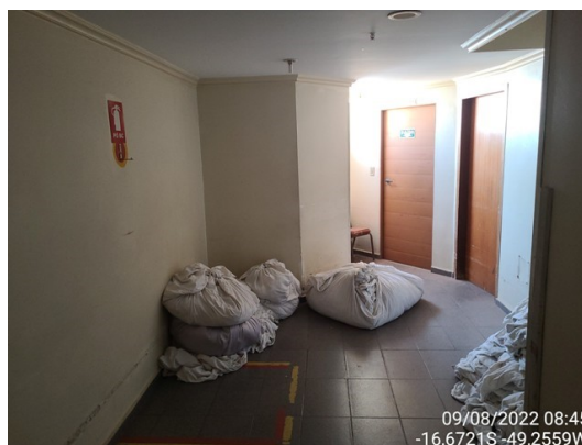
Foto 21 – Outra vista geral do 4º pavimento
