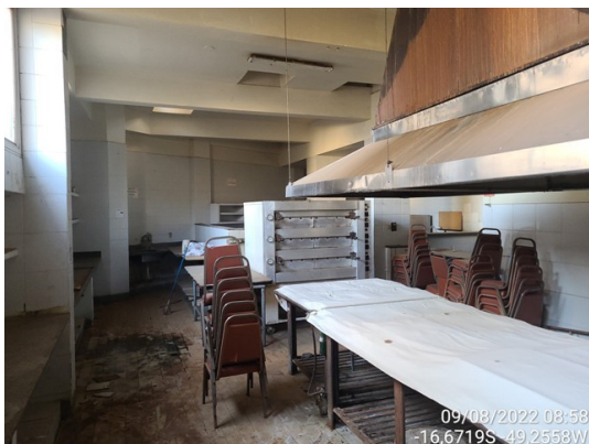
Foto 40 – Outra vista geral do térreo
