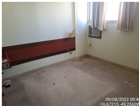
Foto 23 – Outra vista geral do 4º pavimento
