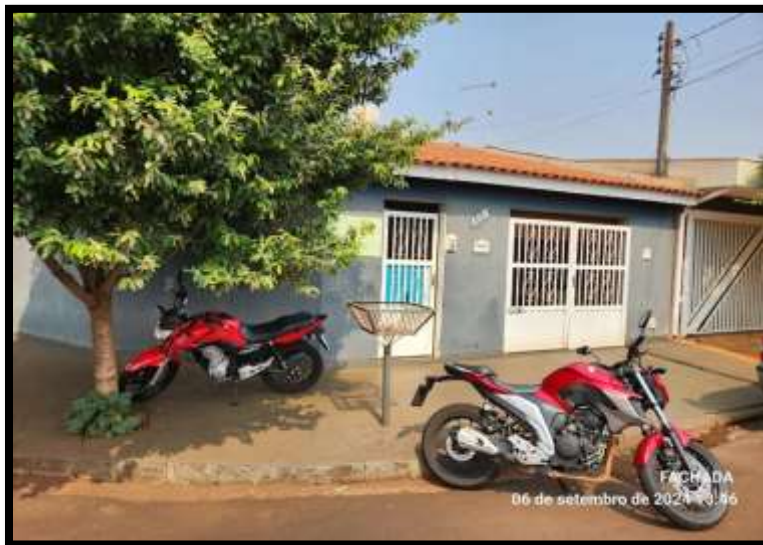
VISTAS DA FACHADA DO IMÓVEL AVALIANDO FRENTE PARA A RUA WALTER SEGATTO
