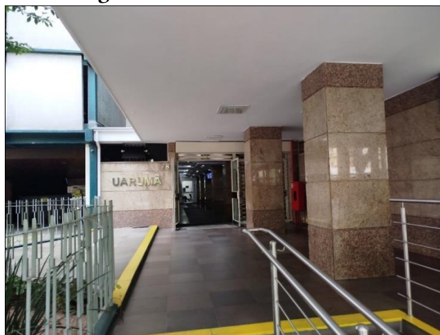
Figura 3 – Entrada do edifício
