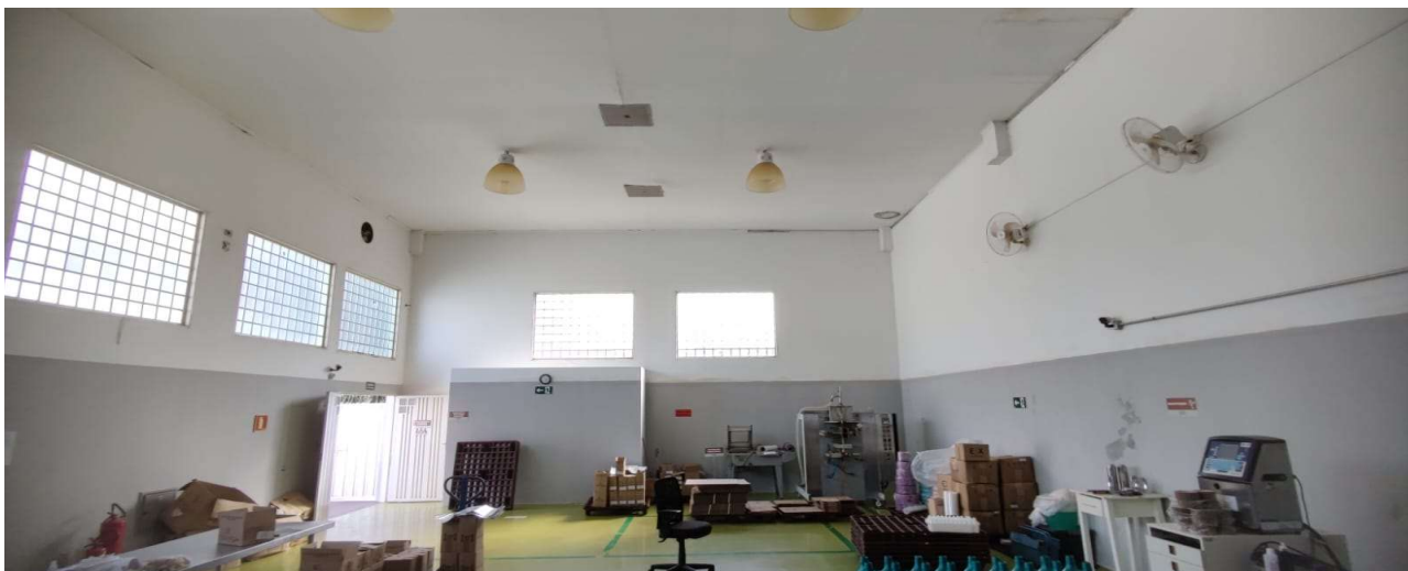
INTERIOR SALÃO FRENTE ESQUERDA IMÓVEL- VISÃO DOS FUNDOS PARA FRENTE RUA em 12/2022.
