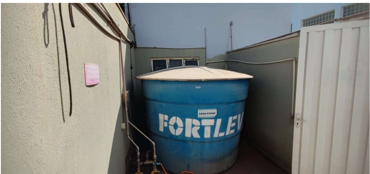
CAIXA ARMAZENAMENTO ÁGUA SITUADO NO CHÃO - ATRÁS RECEPÇÃO/COZINHA em 12/2022
