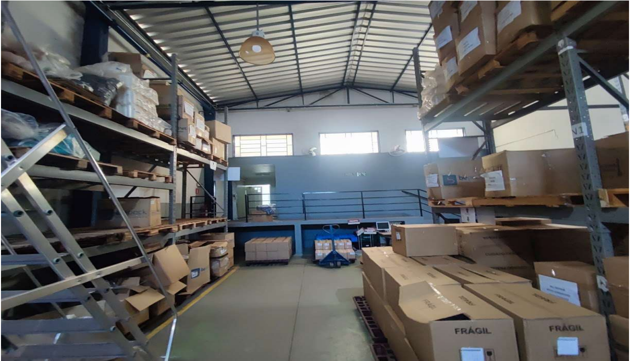
Galpão localizado no lote 5- Perspectiva frente (posição disparador foto) aos fundos do imóvel. Em 09/2025.
