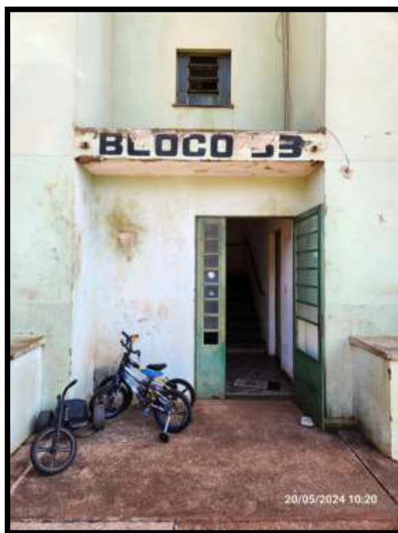
ACESSO AO IMÓVEL AVALIANDO ENTRADA PARA O BLOCO 53 – APTO 32 – 3º ANDAR - 4º PAVIMENTO
