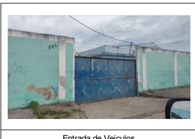
Entrada de Veículos
