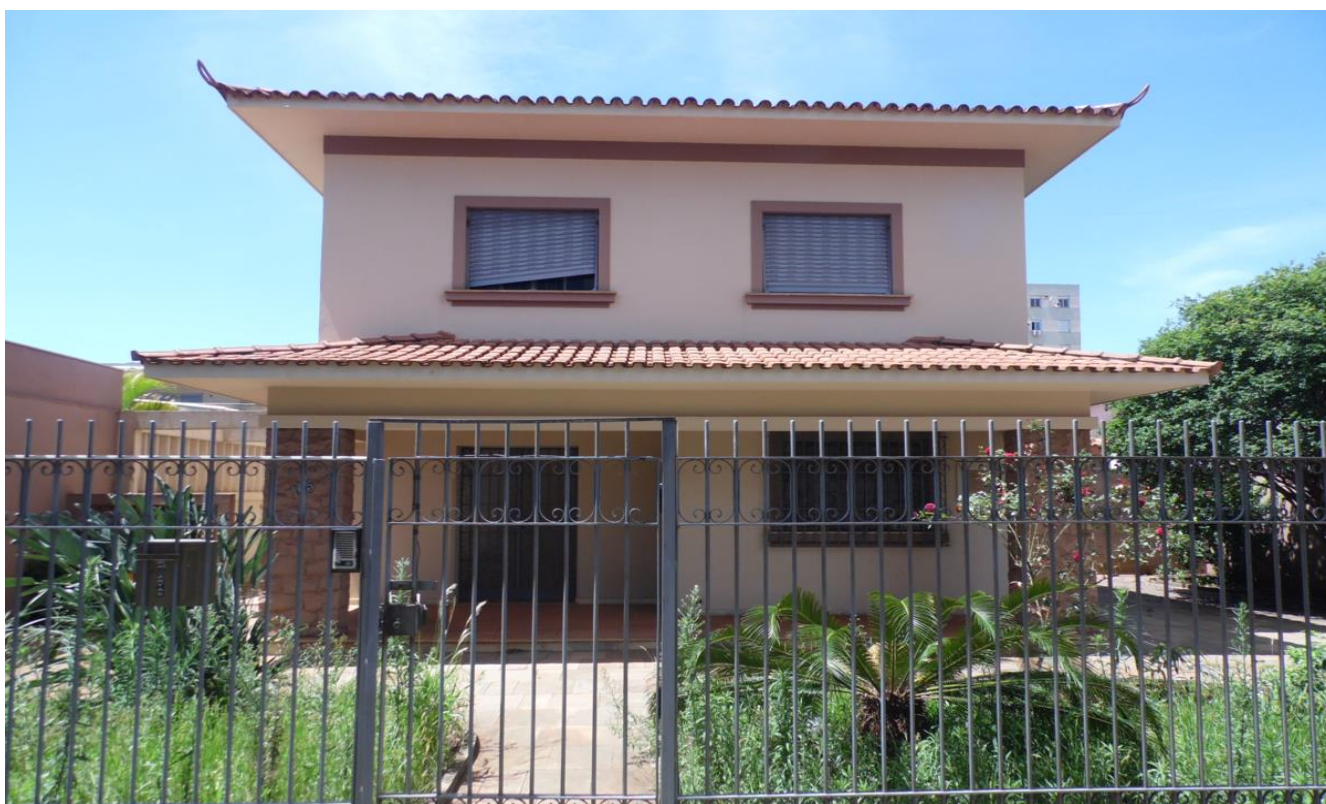
Imagem 02 – No imóvel está edificada uma ampla residência sobradada com área construída de 420.80 m 2 , o padrão de acabamento é elevado e ela está, de maneira geral, em bom estado.
