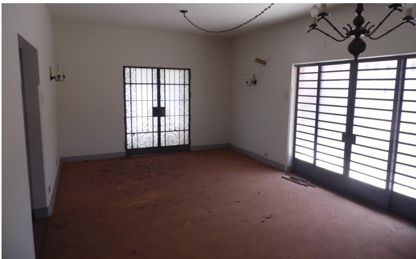
Imagem 12 – Sala de Estar - tacos de madeira, esquadrias em metal, instalação elétrica embutida, paredes rebocadas e pintura em bom estado, em boas condições e sem danos.
