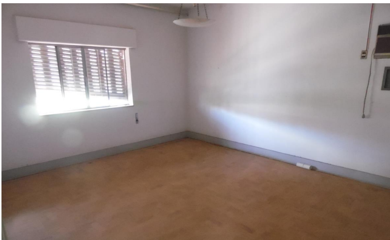
Imagem 20 – O outro Dormitório frontal - tacos de madeira, esquadria em metal, instalação elétrica embutida, também com armário embutido, paredes rebocadas e pintura em bom estado.
