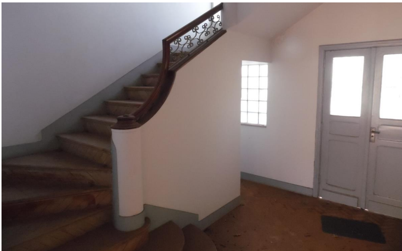
Imagem 11 – Escada de acesso ao Pavimento Superior - degraus em tacos de madeira e corrimão com acabamento detalhado, residência com elevado padrão construtivo.
