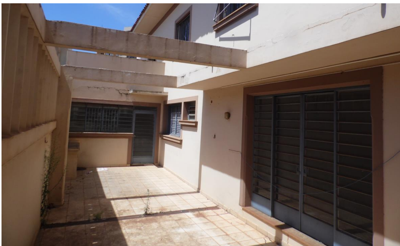
Imagem 04 – Ao fundo, o setor correspondente a Área de Serviço e a Sacada externa, que possui uma área construída de 58.60 m 2 e padrão construtivo inferior ao da residência principal.
