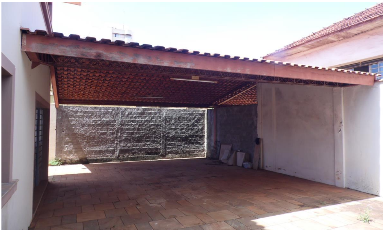
Imagem 07 – Abrigo de Veículos - cobertura executada com treliças metálicas e coberto com telhas de barro, instalações elétricas aparentes e pedras mineiras no piso, em boas condições, e ao fundo o Muro que delimita a confrontação dos fundos, terreno adequadamente delimitado.
