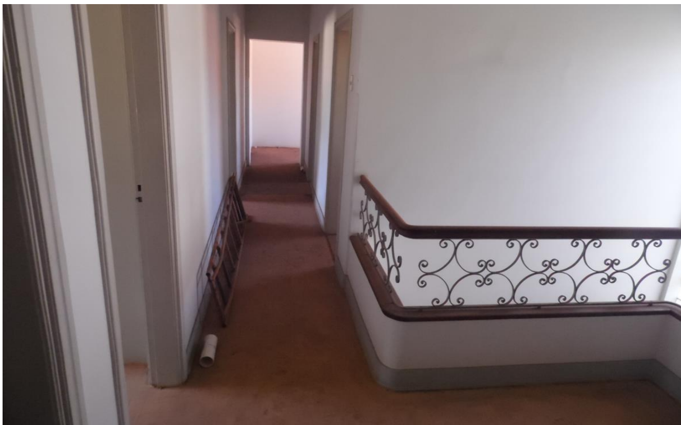
Imagem 17 – Circulação Pavimento Superior - tacos de madeira, paredes rebocadas e pintura em bom estado, o imóvel, de maneira geral, está em bom estado de conservação/manutenção.
