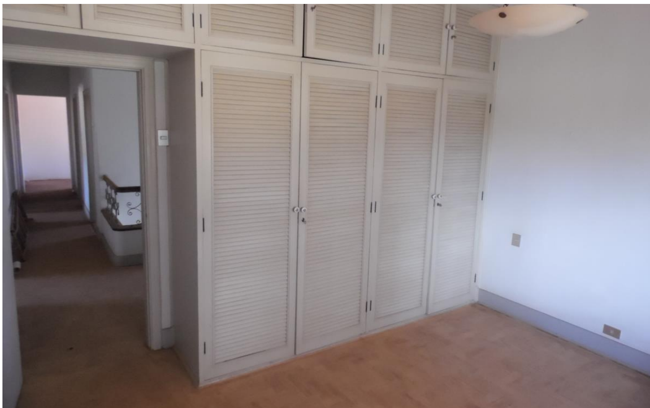
Imagem 19 – Dormitório frontal - tacos de madeira, esquadria em metal, instalação elétrica embutida, armário embutido, paredes rebocadas e pintura em Látex, elevado padrão construtivo.
