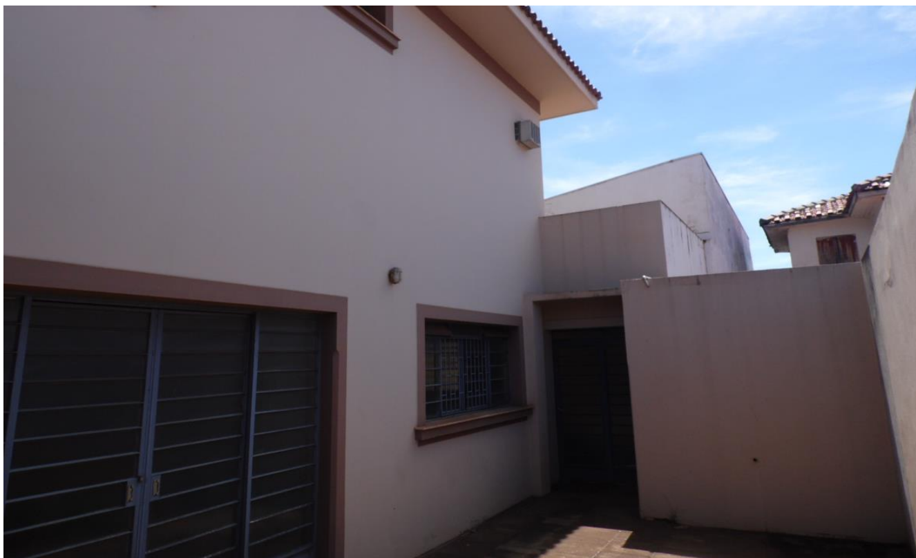
Imagem 09 – Fundos do imóvel - pintura externa em bom estado e sem danos estruturais, e, ao centro, a Área de Serviço sobre a qual está construída a Sacada externa do Pavimento Superior.
