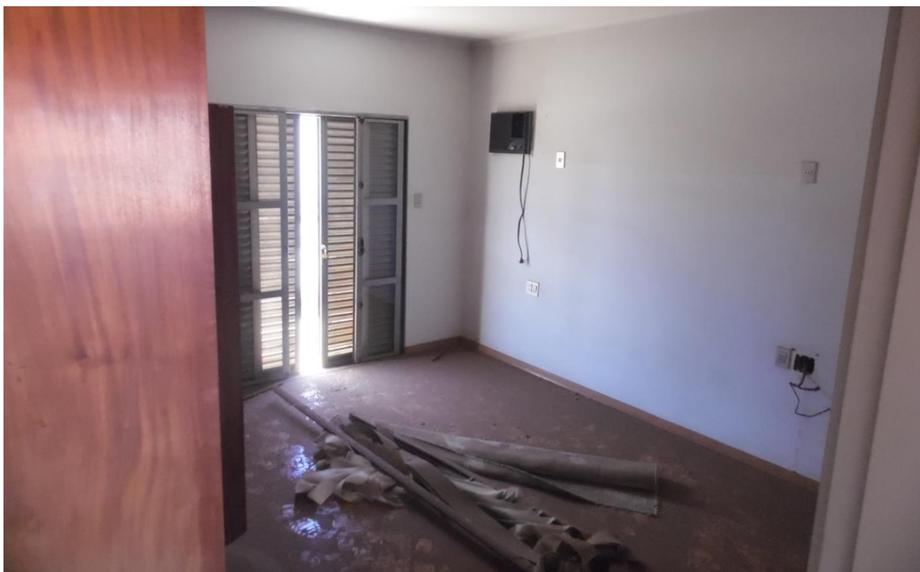
Imagem 26 – No Pavimento Superior também há um Suíte com tacos de madeira, esquadrias em metal, instalação elétrica embutida, armário embutido, paredes rebocadas e pintura em Látex.
