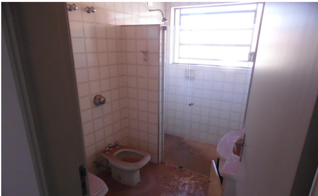
Imagem 25 – O outro Banheiro do Pavimento Superior - pisos cerâmicos, revestimentos até o teto, instalações embutidas, Box, Louças e Metais sanitários antigos mas de boa qualidade.
