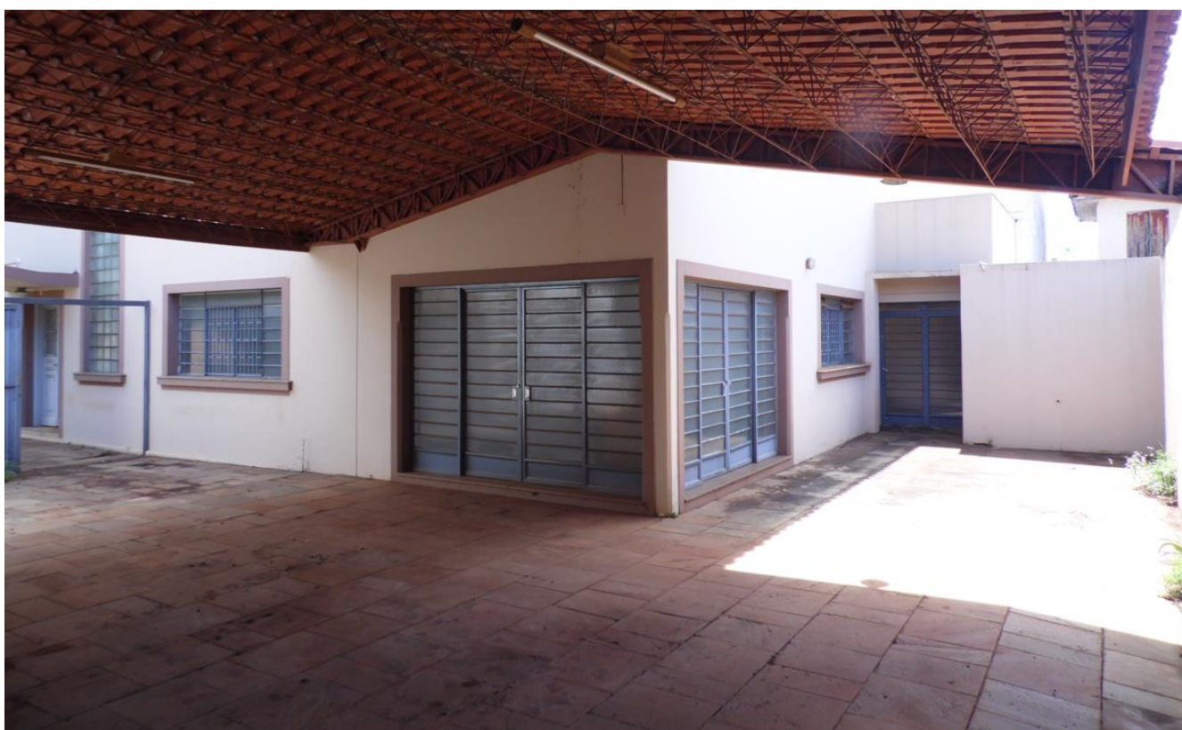
Imagem 08 – Fundos do imóvel - Abrigo de Veículos com treliças metálicas e pedras mineiras assentadas por todo o entorno, divisa dos fundos adequadamente delimitada por Muros.
