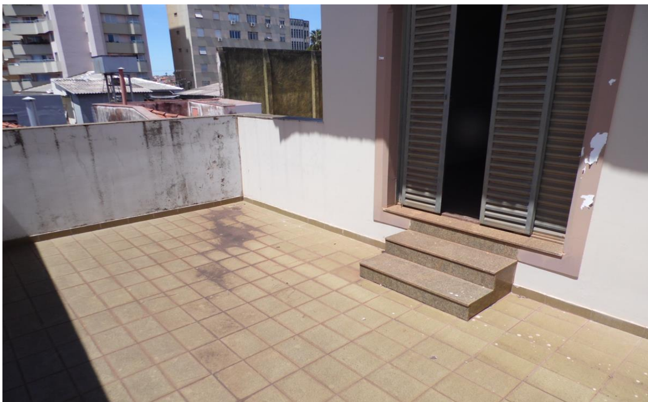
Imagem 28 – Sacada externa - que permite o acesso da Suíte a área externa do Pavimento, construída sobre a Laje da Área de Serviço, com pisos cerâmicos e parapeito em alvenaria.
