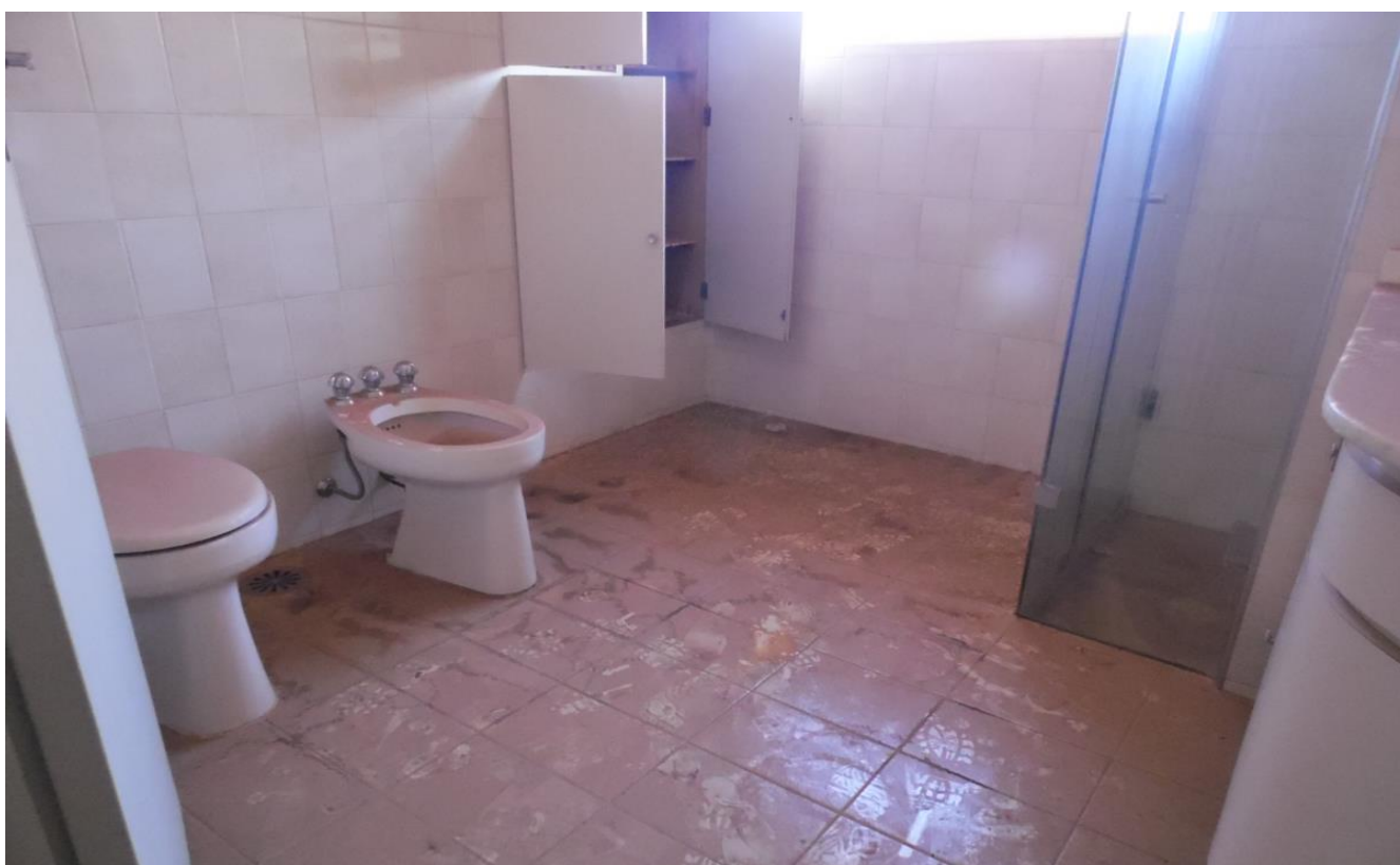
Imagem 24 – Um dos Banheiros do Pavimento Superior - pisos cerâmicos, revestimentos até o teto, instalações embutidas, Box, Louças e Metais sanitários antigos mas de boa qualidade.
