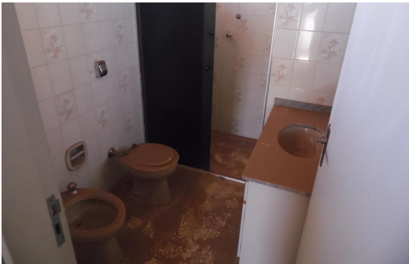
Imagem 27 – Banheiro da Suíte - mesmo acabamento dos outros Banheiros do Pavimento.
