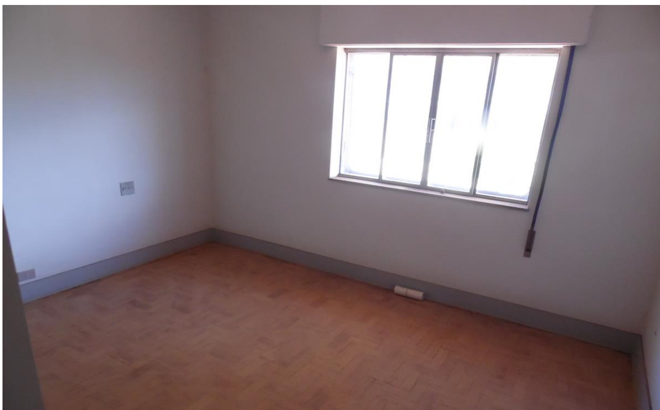
Imagem 18 – Dormitório frontal - tacos de madeira, esquadria em metal, instalação elétrica embutida, armário embutido, paredes rebocadas e pintura em Látex, elevado padrão construtivo.
