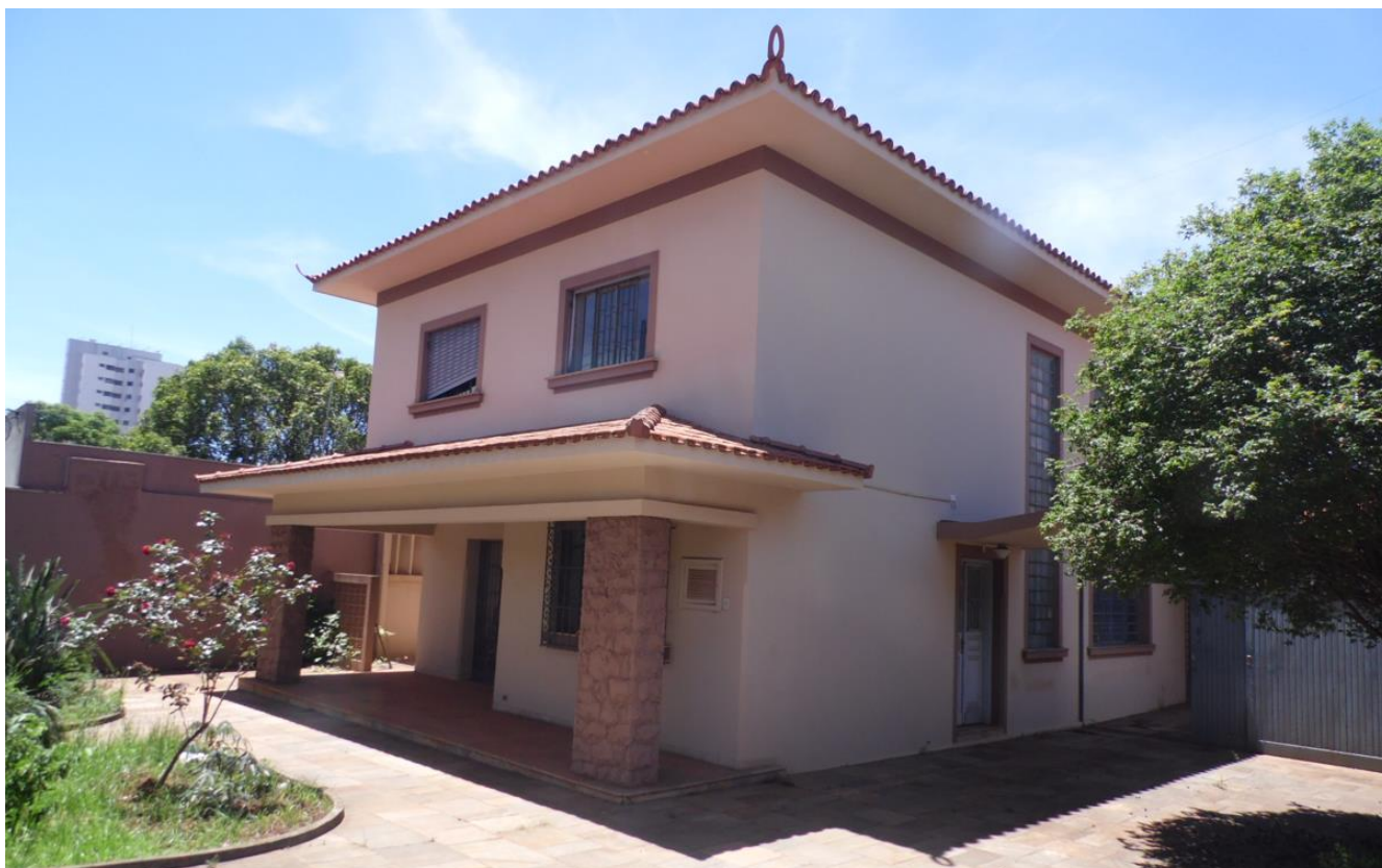
Imagem 05 – Lateral direita - também com a pintura em boas condições e sem danos estruturais.
