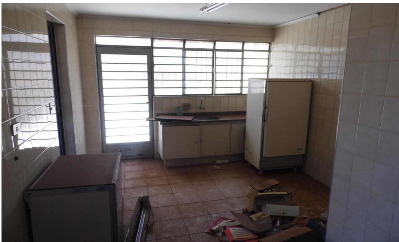
Imagem 16 – Área de Serviço - pisos cerâmicos, revestimentos até o teto, instalação hidráulica e elétrica embutida, esquadrias em metal e sobre a Laje está a Sacada do Pavimento Superior.
