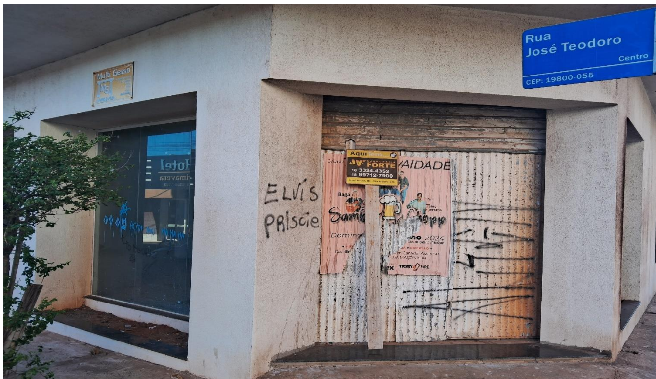
Imagem 03 – O Edifício Sede do Lumiere Executive Hotel está, ao que tudo indica, em situação de abandono, pois as obras estão paralisadas há bastante tempo, o que impossibilitou o acesso ao seu interior para uma inspeção mais detalhada do Sistema Fotovoltaico instalado no local.
