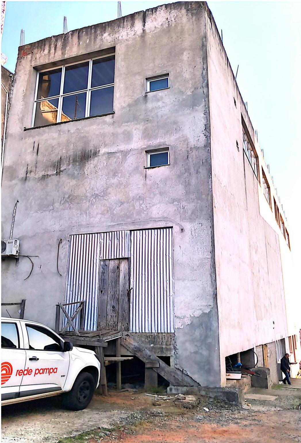
Figura 6 Prédio Inacabado anexo ao Prédio A nos fundos
