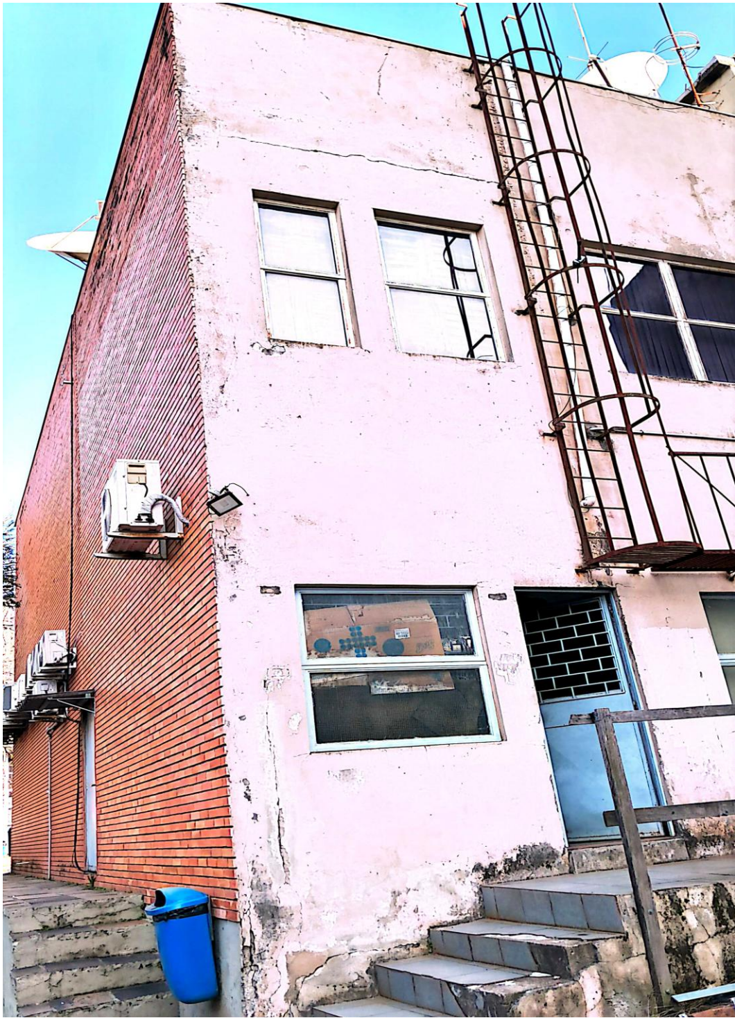
Figura 4 Fundos do Prédio A ou Prédio da TV
