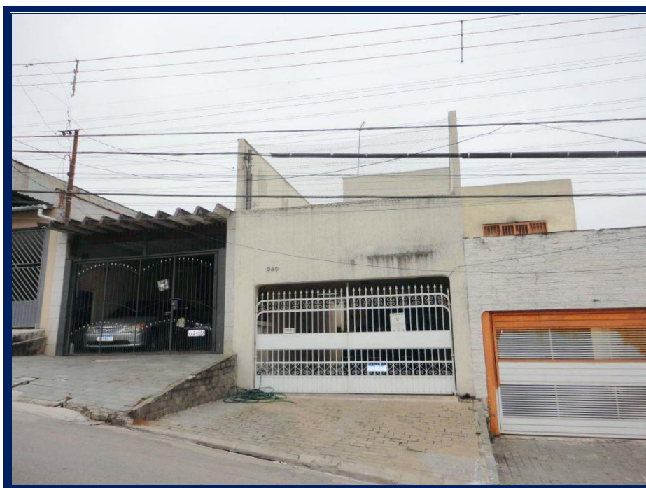
Vista da frente do imóvel avaliando.
