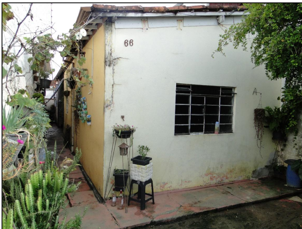
FOTO 03: Fachada principal e lateral da Casa nº 66 da Rua Padre João Renaudin.
