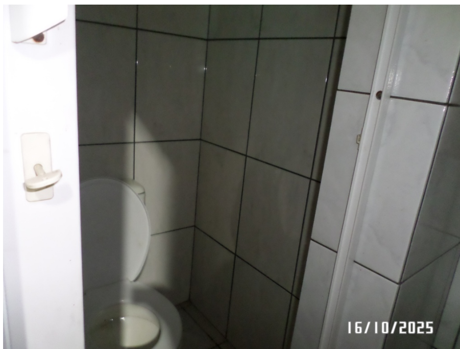
FOTO 22 – VISTA PARCIAL TÉRREO – BANHEIRO SALÃO COMERCIAL.
