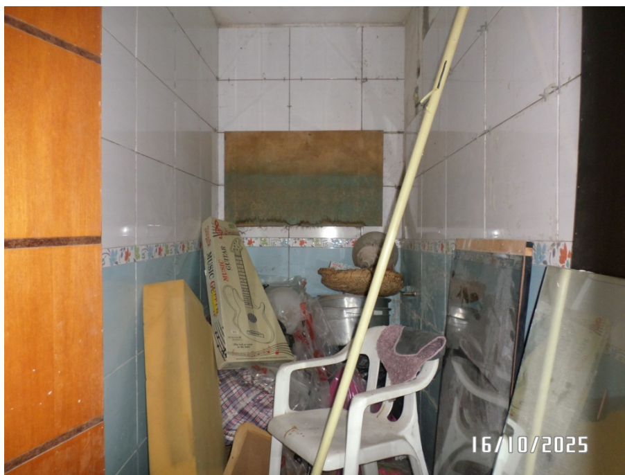
FOTO 13 – VISTA PARCIAL PAV. SUPERIOR – BANHEIRO SEMI ACABADO.
