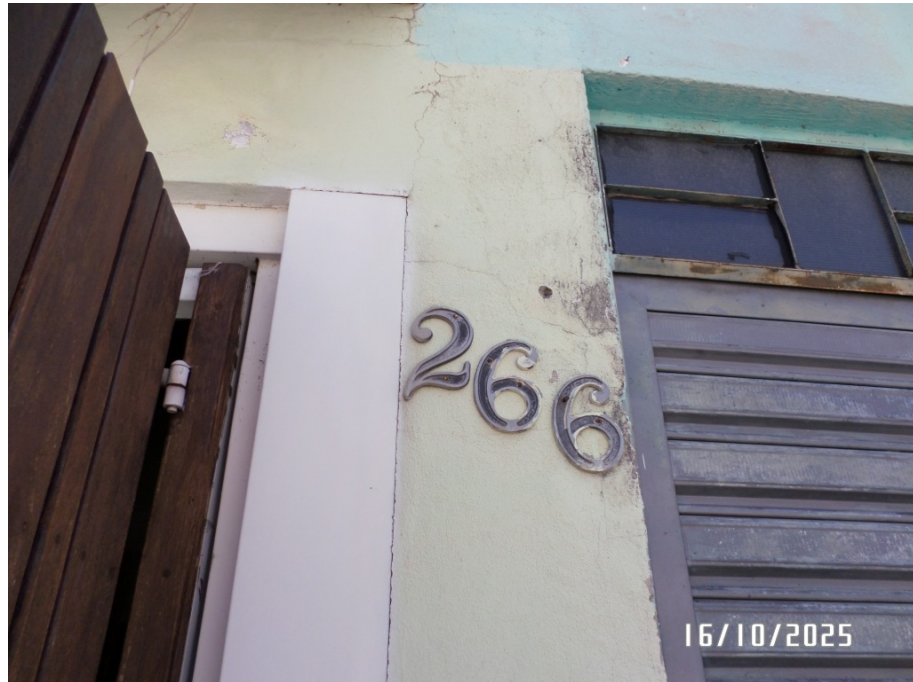
FOTO 01 – VISTA DO EMPLACAMENTO DO IMÓVEL VISTORIADO.
