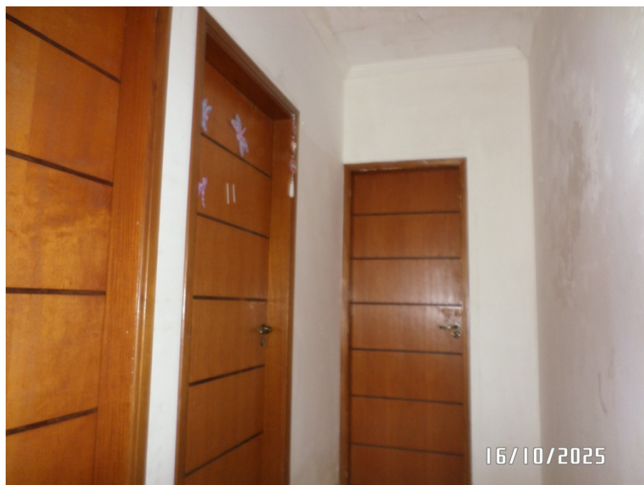
FOTO 12 – VISTA PARCIAL SUPERIOR - HALL.
