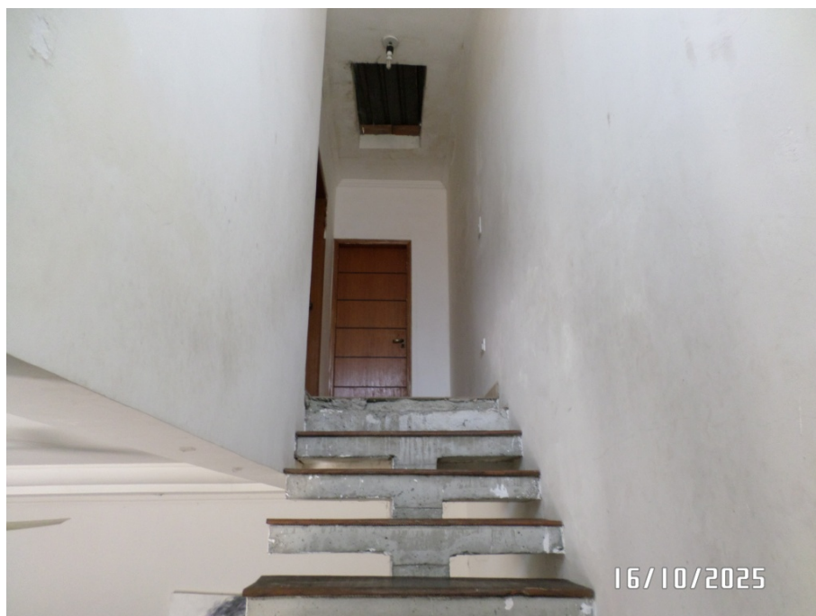
FOTO 11 – VISTA PARCIAL SUPERIOR – ESCADA E HALL.
