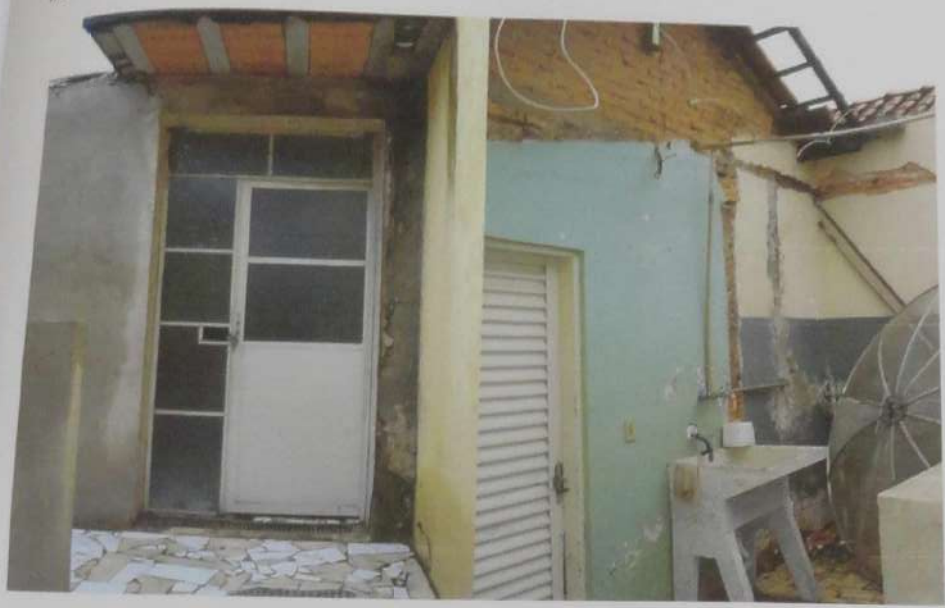
Foto 08- Vista da casa dos fundos ainda sem acabamentos.
