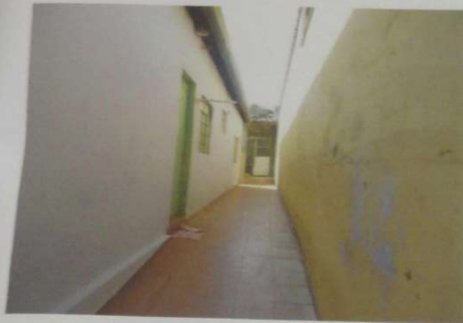
Foto 02 Vista do corredor de acesso à casa da frente e a dos fundos.
