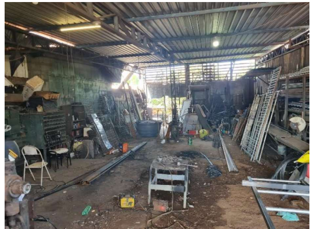
Interior do Galpão
