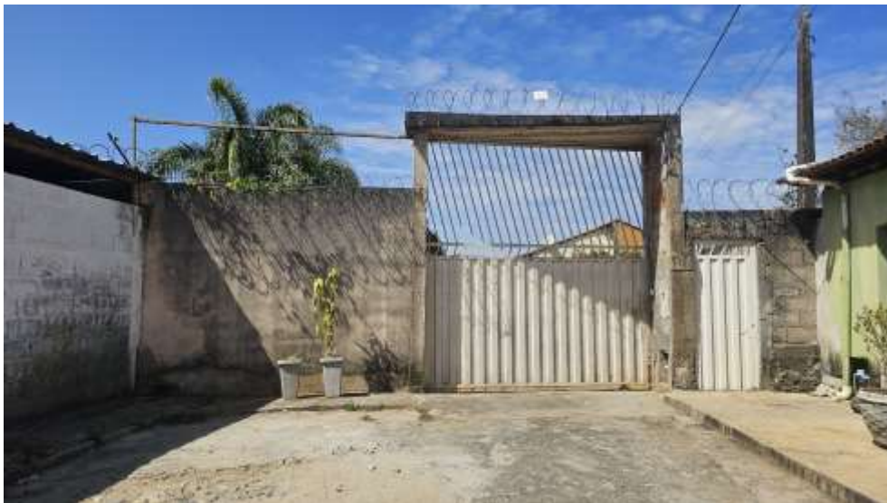
Fotografia 2 – Entrada do imóvel objeto da lide.
