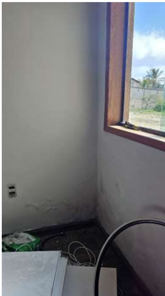
Fotografia 7 – Infiltração por capilaridade ascendente em um dos quartos.
