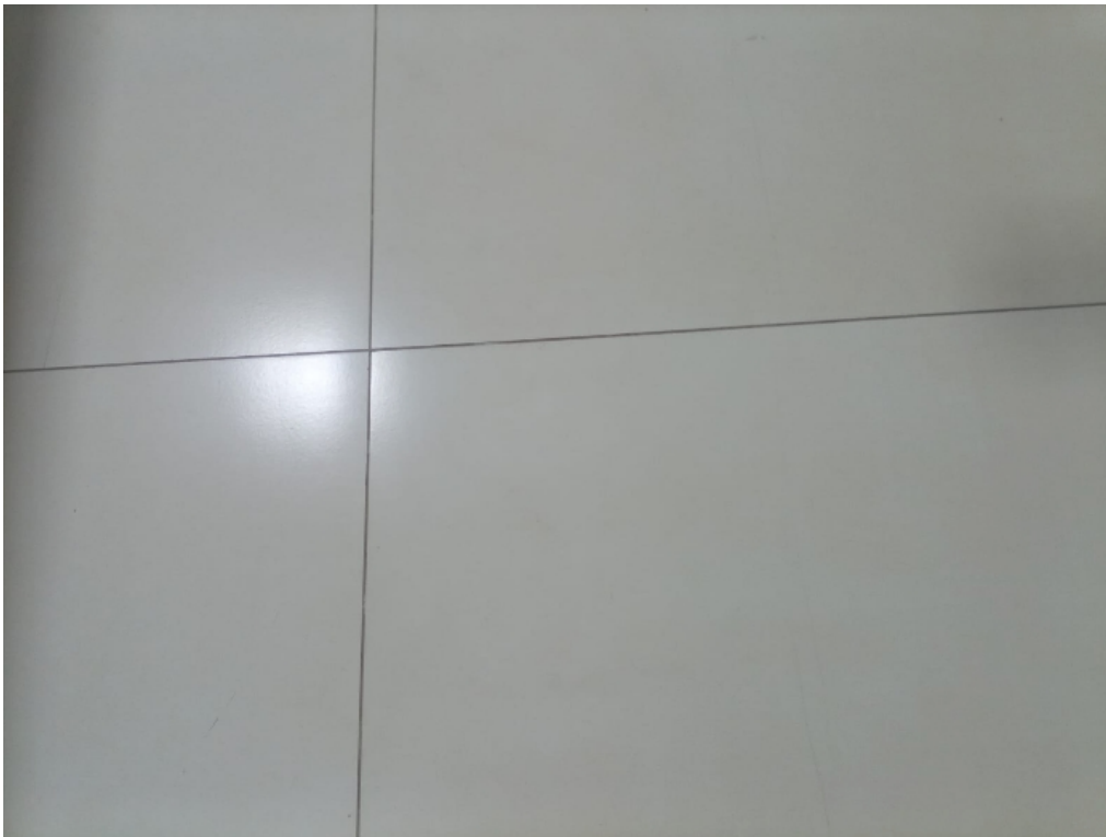
Figura 4 – Imóvel localizado na Avenida Vereador Francisco da Silva, nº 607, Qd-07, Lt-15, Centro, Nova Veneza-GO.
