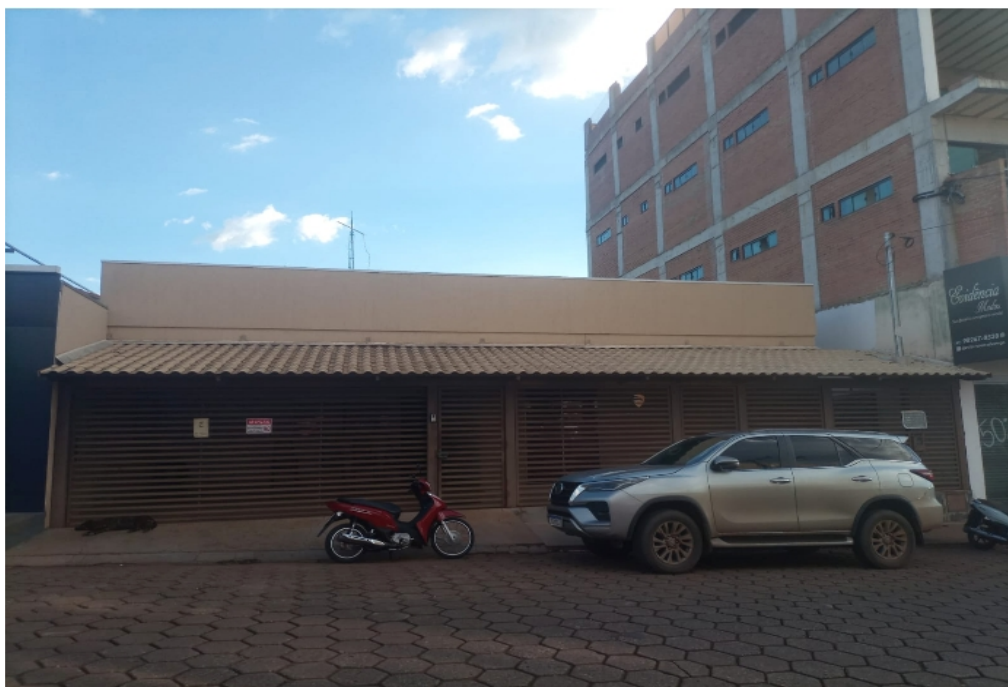
Figura 2 – Imóvel localizado na Avenida Vereador Francisco da Silva, nº 607, Qd-07, Lt-15, Centro, Nova Veneza-GO.
