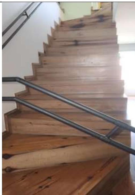
Escada acesso pavimento superior
