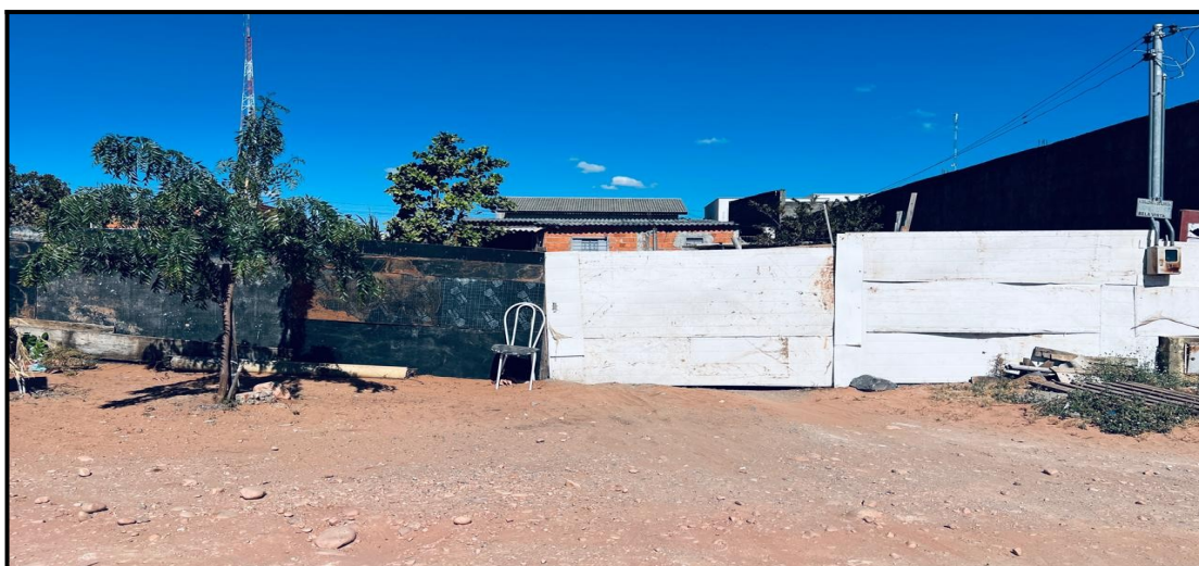
Foto 01 – Parte frontal do imóvel (Vista externa).
