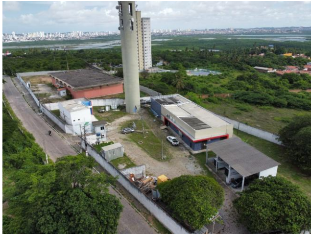
Área operacional da Tim – Não faz parte da valoração dos terrenos.
