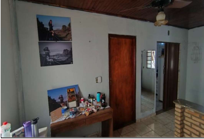
Foto 12 - Copa - revestimentos e esquadrias
