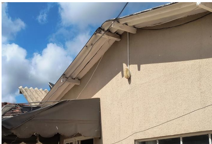
Foto 30 - Detalhes do telhado
