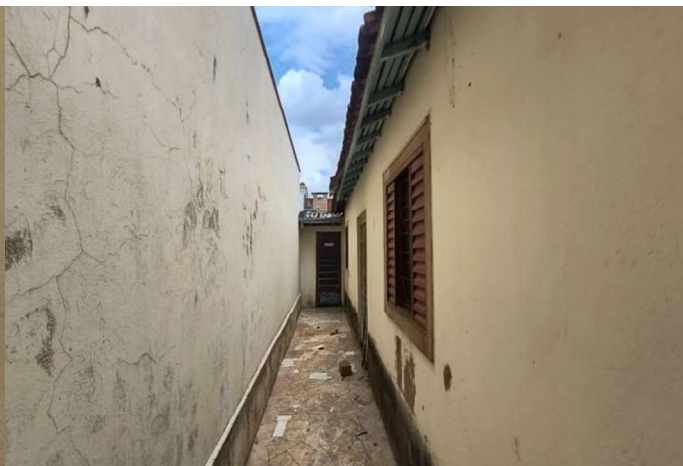
Foto 04 - Corredor lateral - Fundos Garagem
