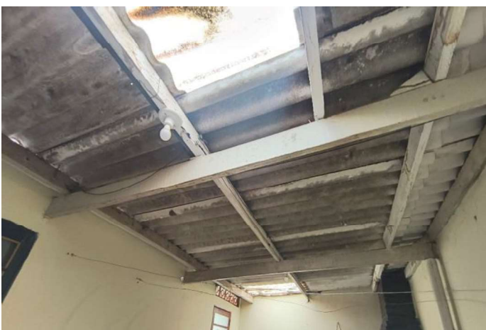
Foto 29 - Cobertura do quintal
