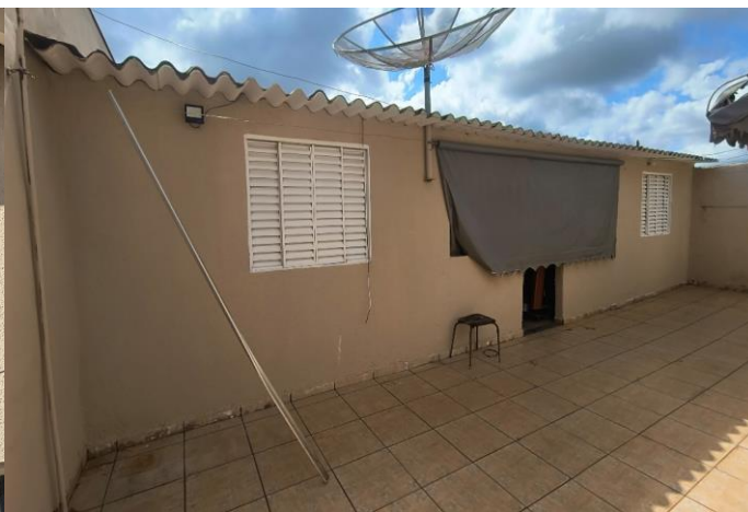
Foto 31 - Fachada da Edícula
