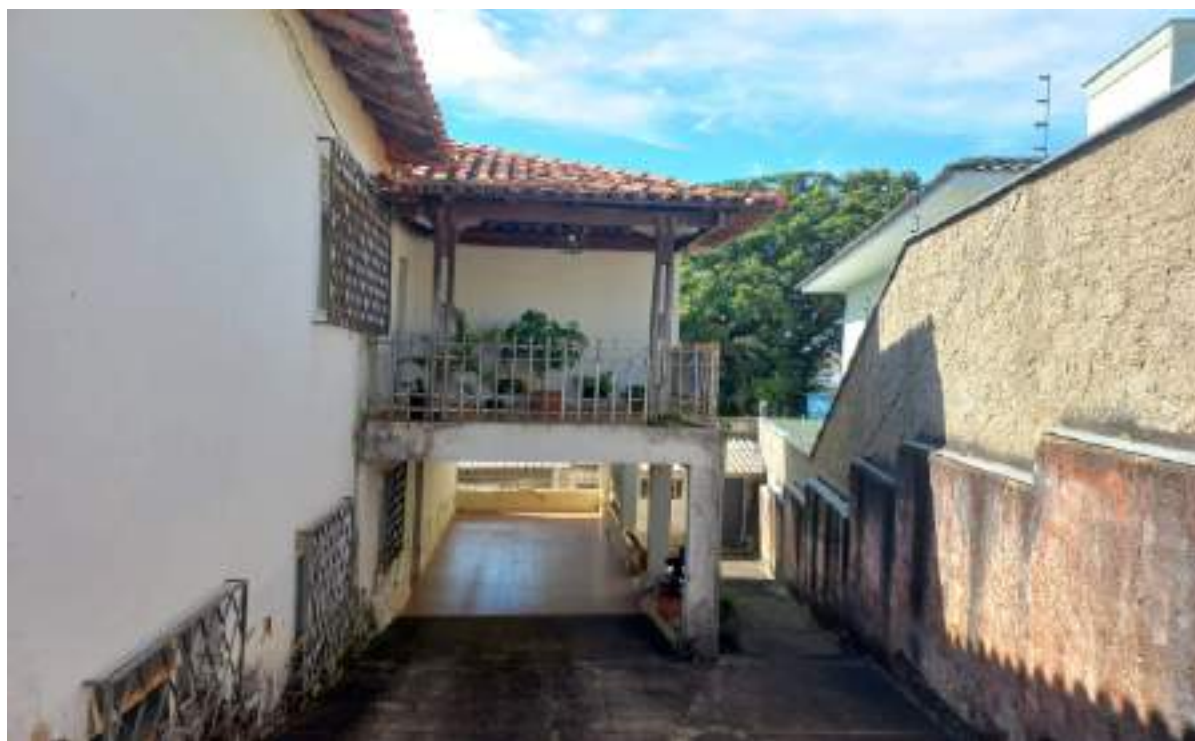
VISTA INTERNA DA GARAGEM (PARTE COBERTA) E RAMPA DE ACESSO
