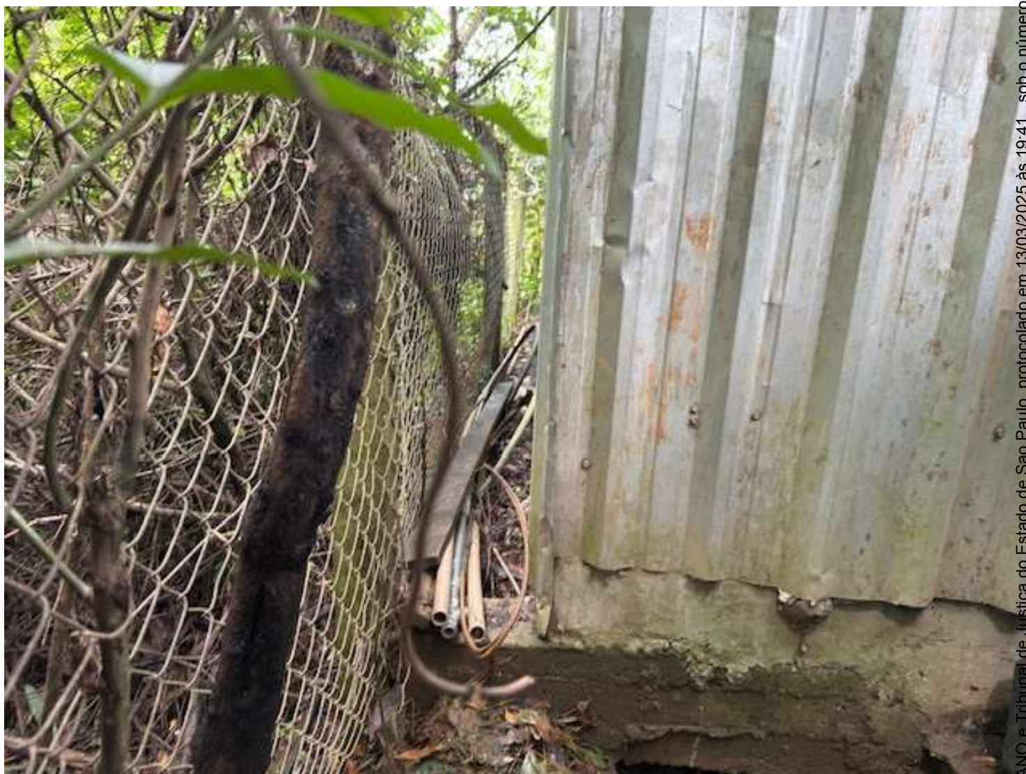
Foto 10: Vista da cerca de confrontação do imóvel 423 da Rua Philip Leiner com imóvel avaliando.
