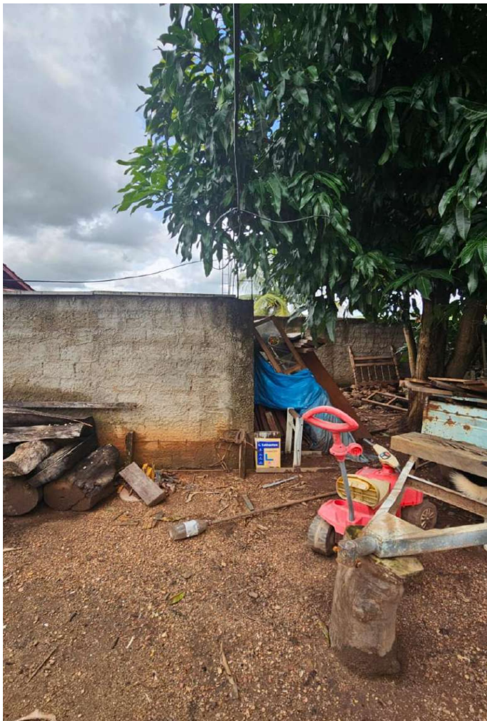
DIVISA DO MURO - PARTE ESCRITURADA E PARTE NÃO DOCUMENTADA
