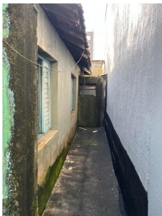
Foto 7 - Vista da construção existente.
