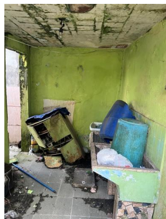
Foto 10 - Vista da construção existente.
