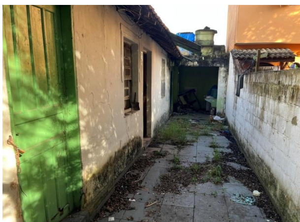
Foto 5 - Vista da construção existente.
