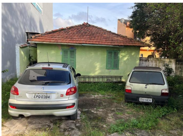
Foto 3 - Vista da construção existente.
