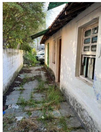
Foto 8 - Vista da construção existente.
