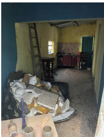
Foto 9 - Vista da construção existente.
