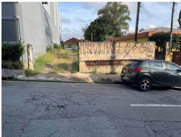
Foto 1 - Vista frontal do imóvel objeto.
