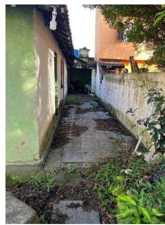
Foto 4 - Vista da construção existente.
