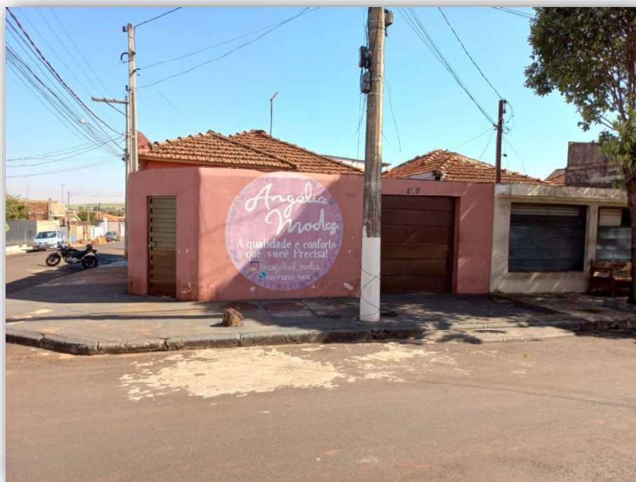
Fachada do imóvel – Av. Presidente Vargas, nº 435
