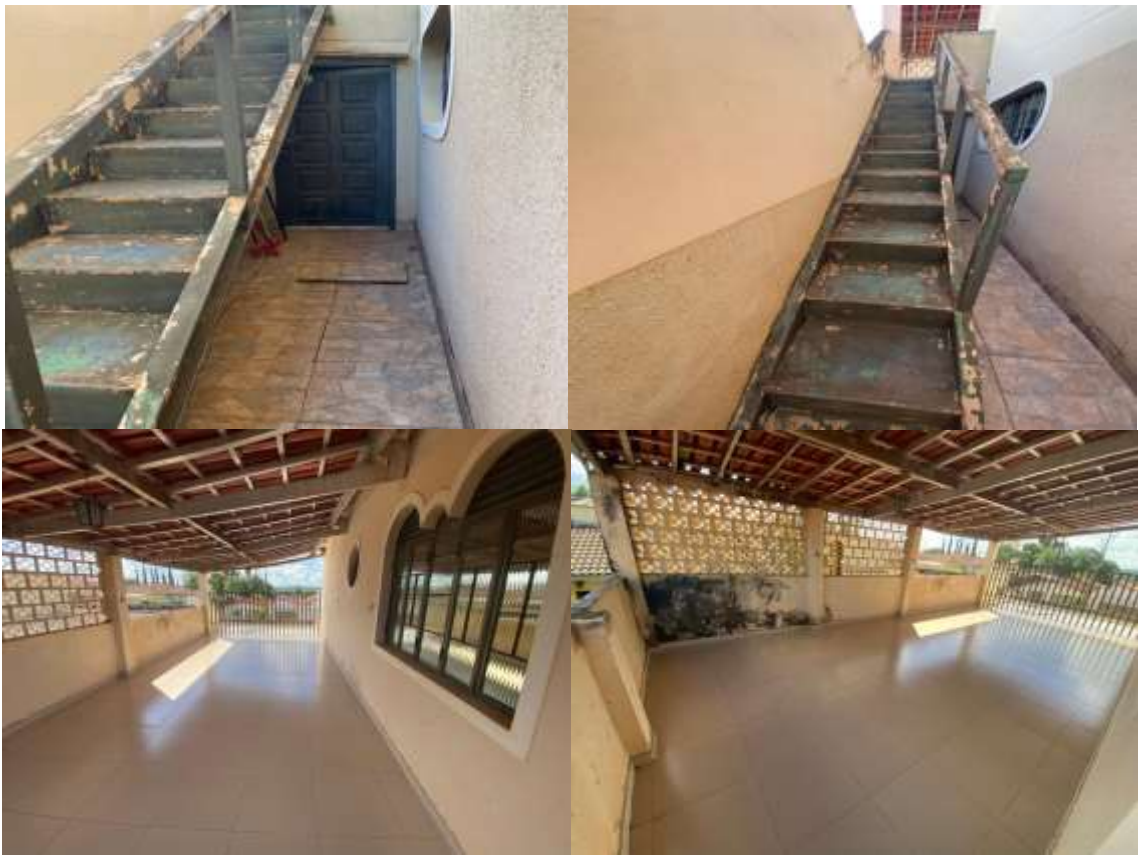
FOTOS 1.3 - ALPENDRE - “2º PAVIMENTO”
