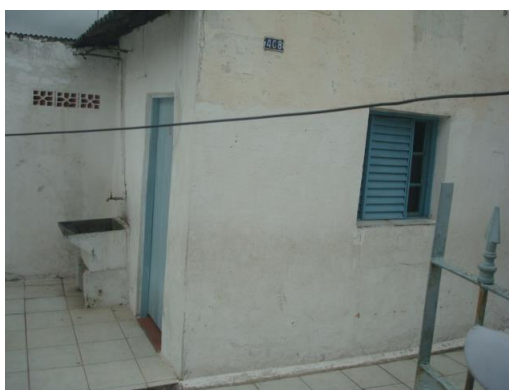
(visão do primeiro dos dormitórios)
