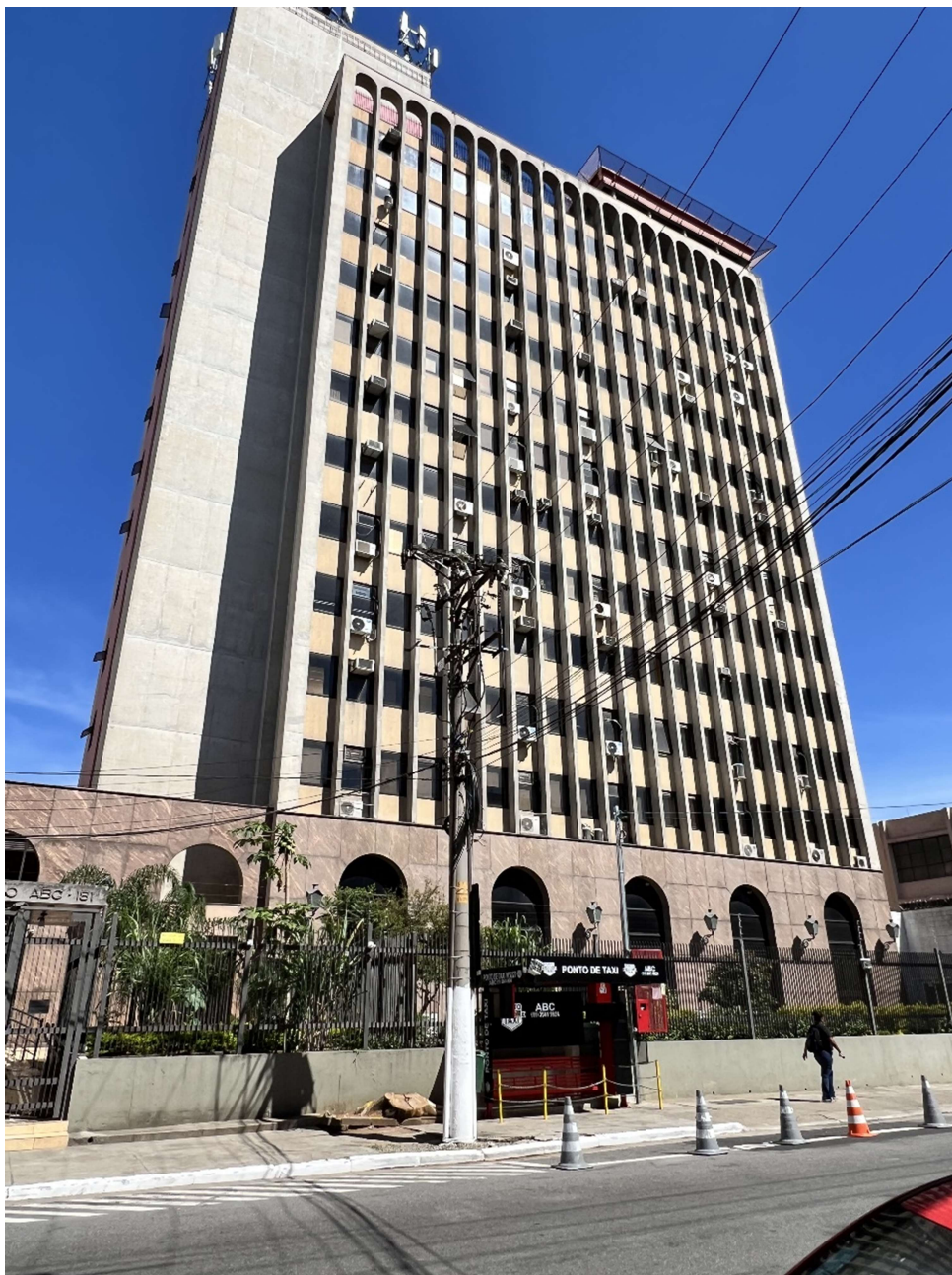
Aspectos gerais fachada
