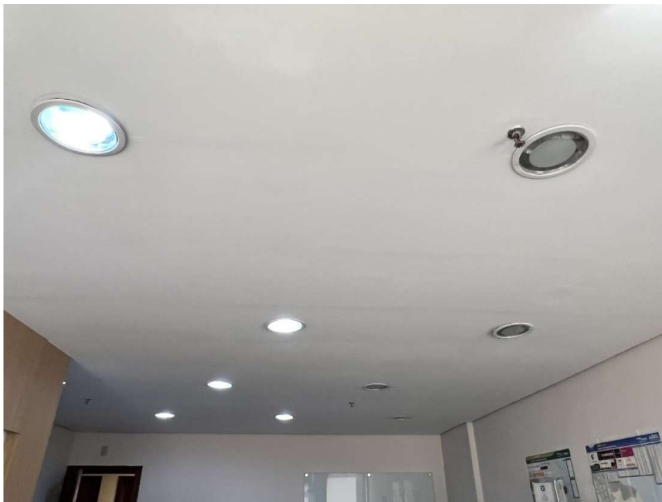
Aspectos gerais sala 102
