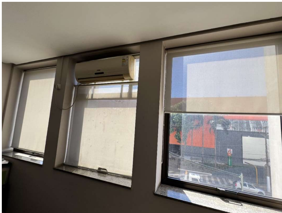
Aspectos gerais sala 102
