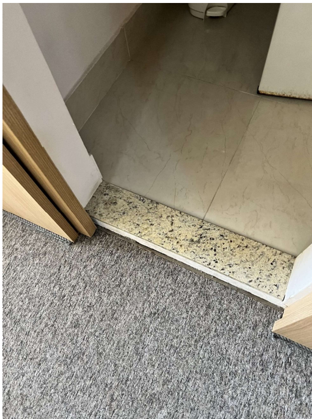
Aspectos gerais sala 102
