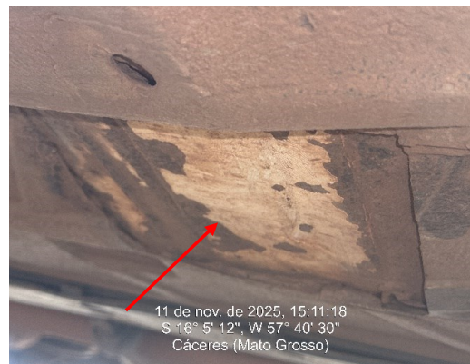
Fotografia 5. Vista inferior da chapa metálica implantada no local destinado à gravação do NIV.
