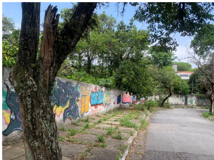
Visão do muro lateral
