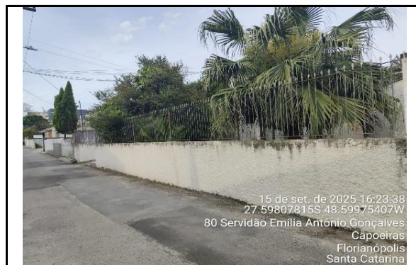
Fachada do Avaliando
