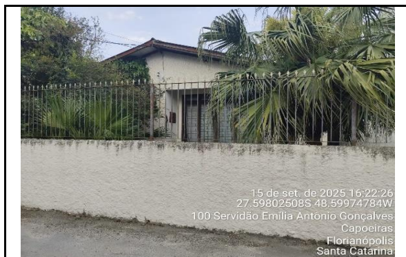
Fachada do Avaliando
