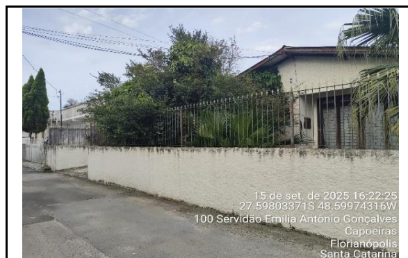
Fachada do Avaliando
