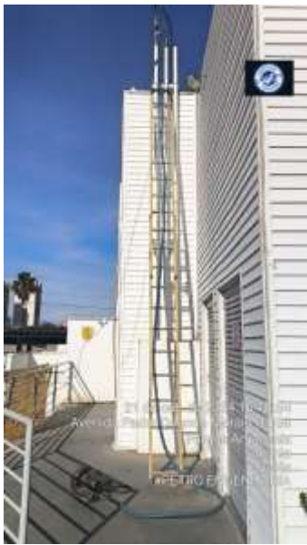
Figura 10 - Registro fotográfico no momento do teste de estanqueidade
