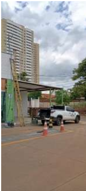
Figura 11 - Registro fotográfico no momento do teste de estanqueidade
