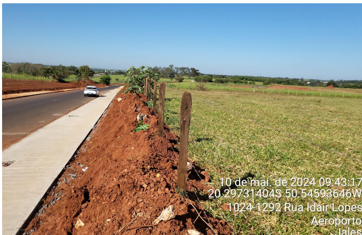
Foto 08: Asfalto e calçamento na frente do imóvel
