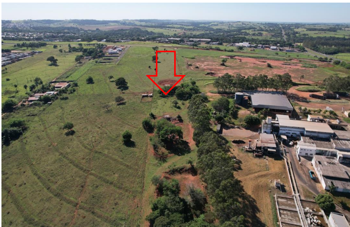
Foto 03: Foto aérea do imóvel avaliando
