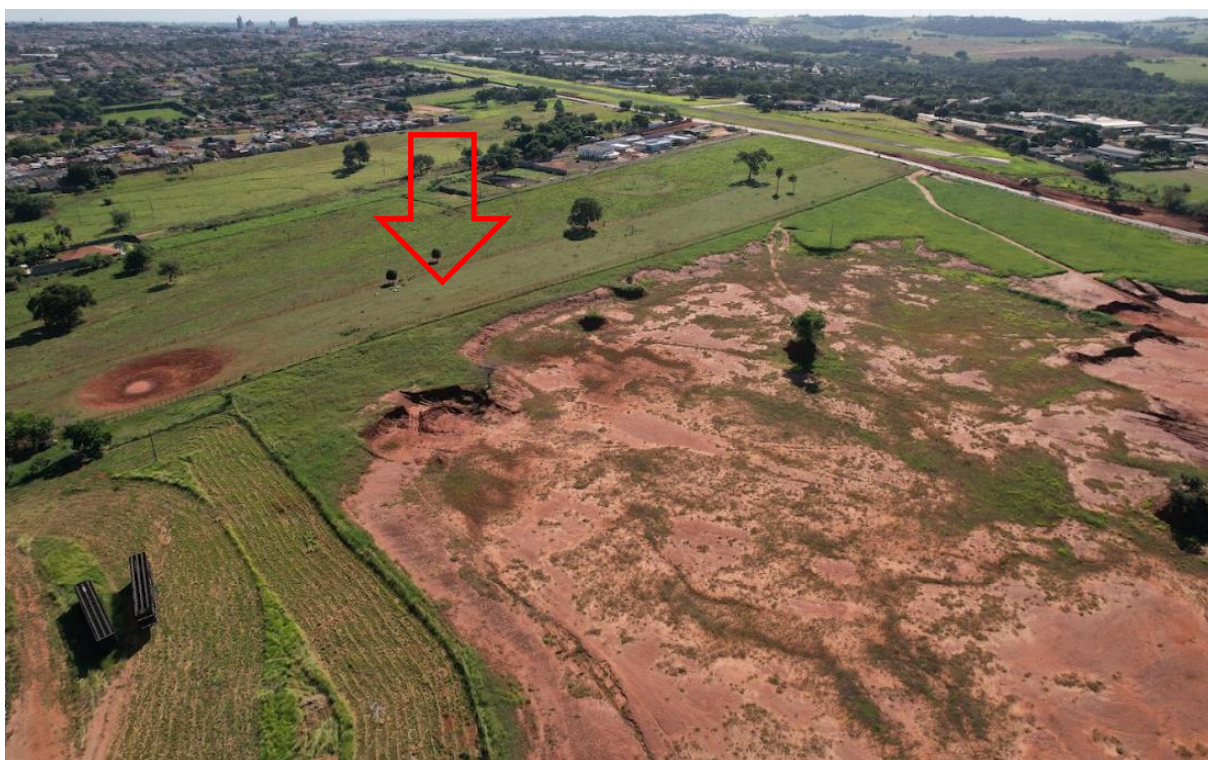
Foto 02: Foto aérea do imóvel avaliando
